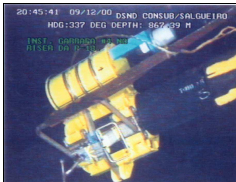
Figura V.3 - Garrafa 4 instalada no riser da P18 na profundidade de 867 m.
