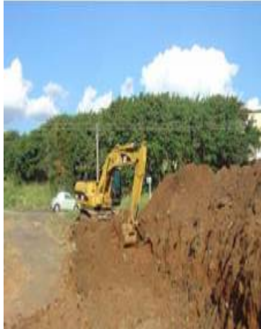
Figura 11 - Início da obra do Projeto Pró-Tijuco Fonte: FIPAI/PMSC/EESC/USP
