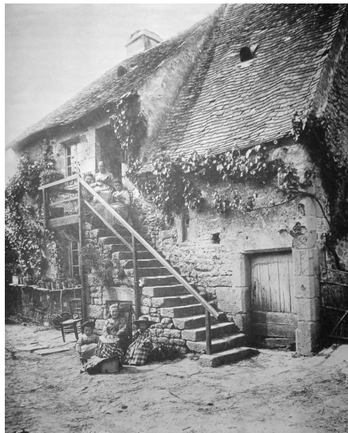
(20 ) Casa camponesa francesa construída com pedras e telhado de palha não sofreu muitas transformações desde a Idade Média.
