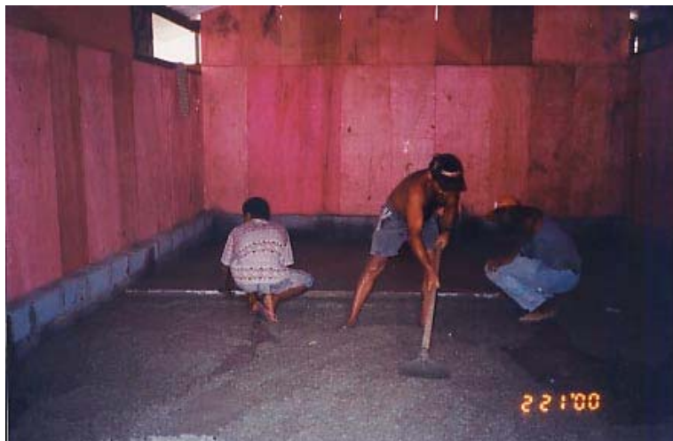
Fotografia 57: Moradores fazendo o piso da nova Igreja.
