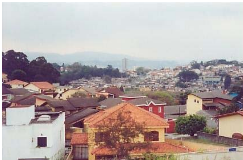
Fotografia 102: Telhados diversificados. Foto: Robson, manual, 2004.
