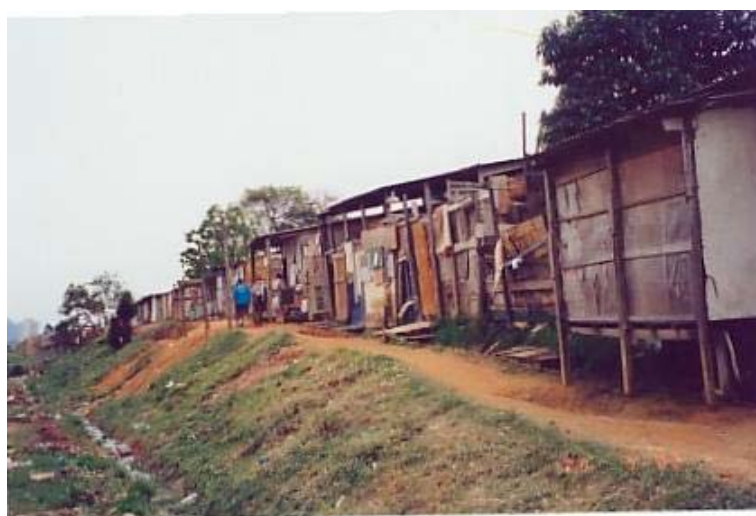
Fotografia 38: Barracos suspensos ou encostados no chão - 2004. Foto: Robson, manual, 2004. 16
