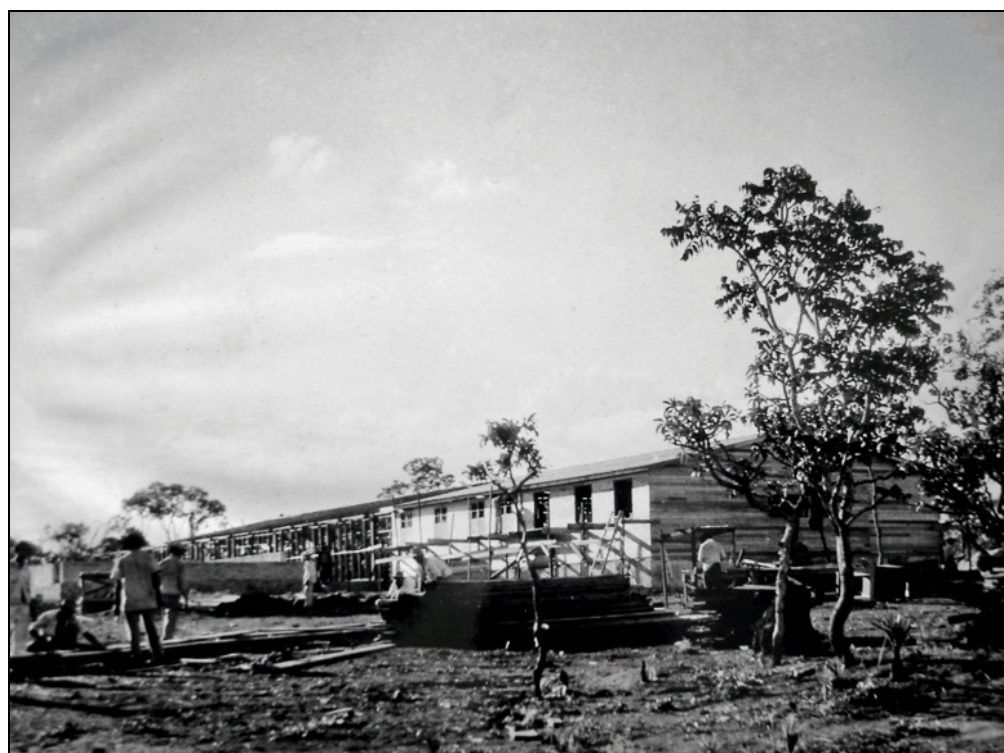
Construção do hospital HJKO, em abril de 1957*.
