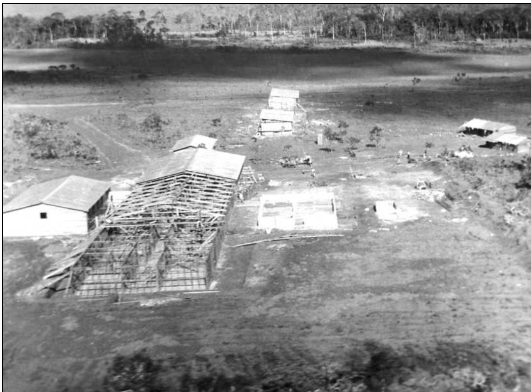
Acampamento dos operários - primeira fase de construção do HJKO, março de 1957*.
