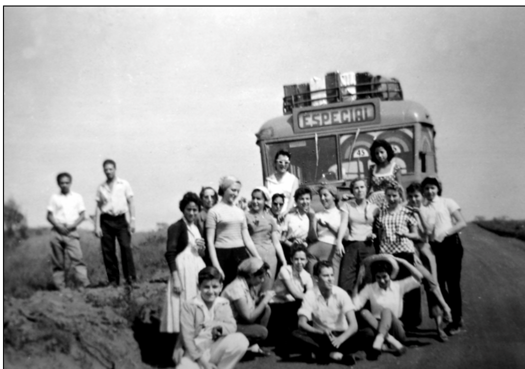
Chegada de familiares e amigos dos trabalhadores ao canteiro de obras*
