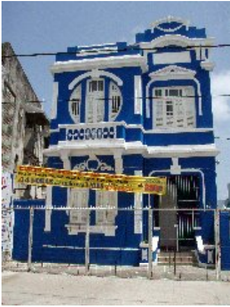
Figura 130: Edificação à Rua Oswaldo Cruz, nº. 294. Bairro da Boa Vista – Recife - PE. Crédito fotográfico: acervo do autor.
