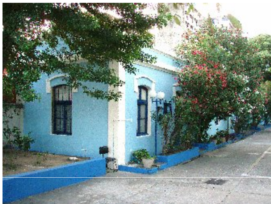
Figura 76: Antigo Escritório de Atendimento ao Público E.L.O. na Rua da Aurora – Recife – PE. Fonte: acervo do autor.
