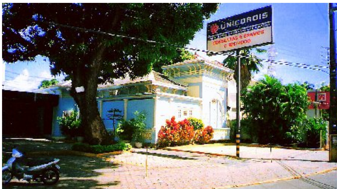
Figura 94: Residência à Rua da Hora, nº 906. Bairro dos Aflitos – Recife – PE. Crédito fotográfico: acervo do autor.
