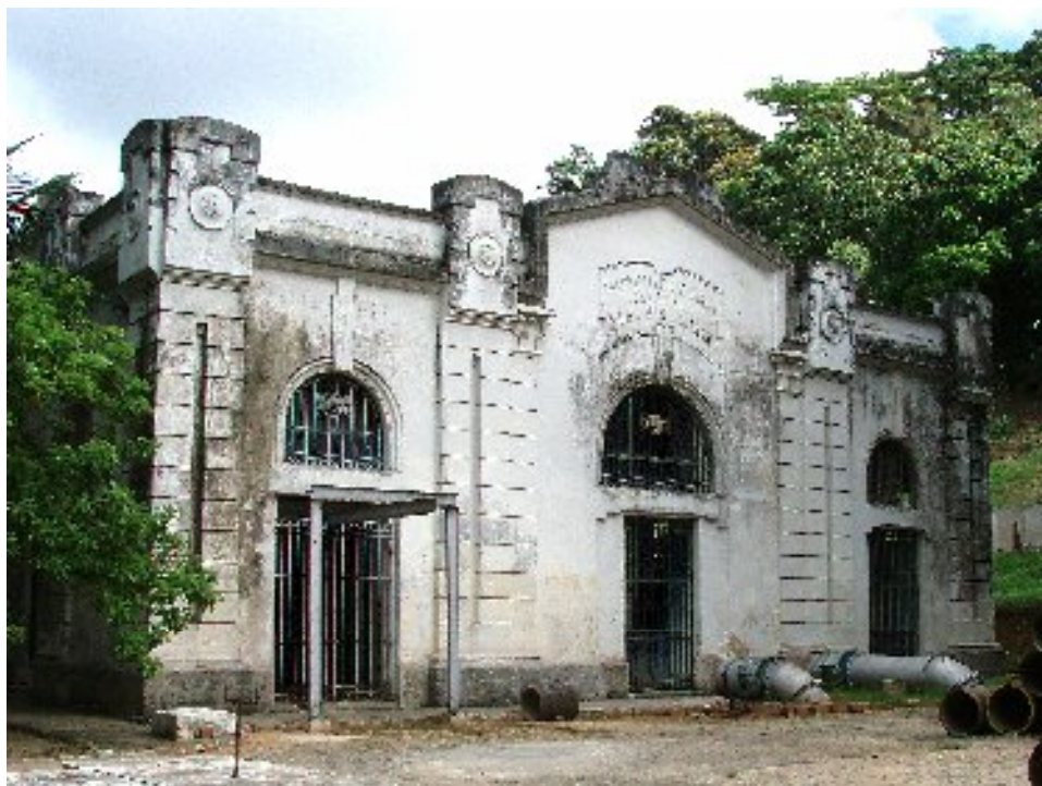
Figura 81: Casa dos filtros em Gurjaú – Cabo de Santo Agostinho – PE. Fonte: acervo do autor.
