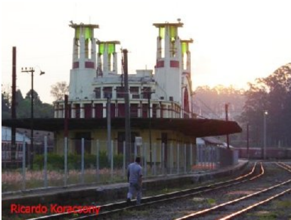
Figura 43: (1.7.1.3.5.1 – Edificação pública. 1.7.1.3.5.1.1 – Estação Mairinque – Mairinque – SP):A estação, em 09/2002. Foto Ricardo Koracsany. Disponível em: www.estacoesferroviarias.com.br/m/mairinque.htm
