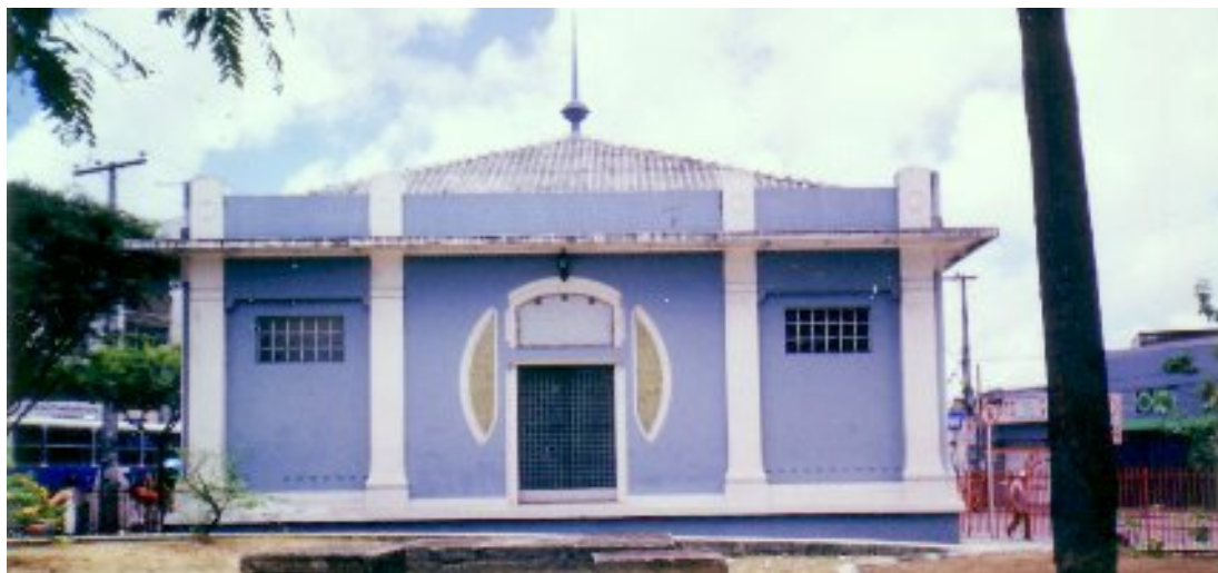
Figura 72: Estação Elevatória. Largo da Paz. Bairro de Afogados – Recife – PE. Crédito fotográfico: acervo do autor.
