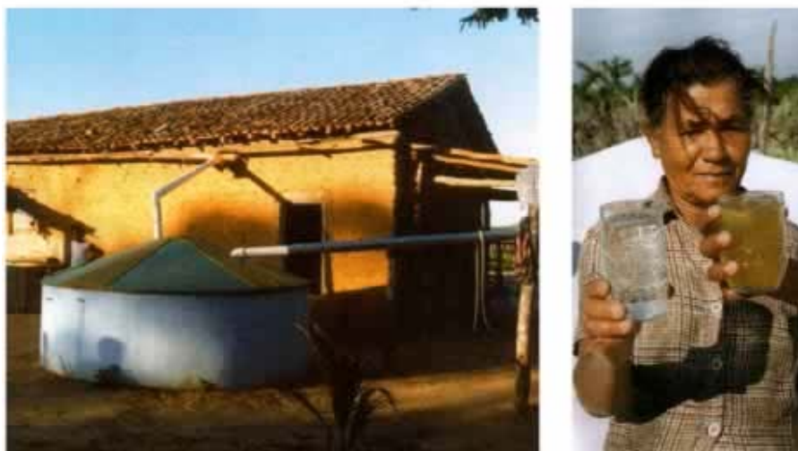
Figura 6. Casa com captação de água da chuva e armazenamento em cisterna, e ao lado comparação entre o estado visual de águas da cisterna e do barreiro.
