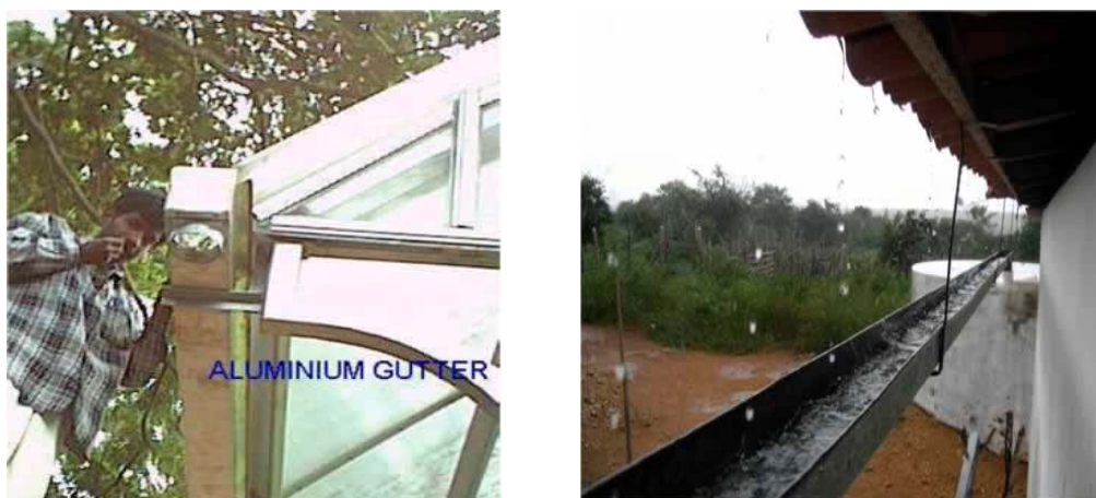
Figura 10. Instalação da calha de alumínio e em seguida a água da chuva conduzida pela calha
