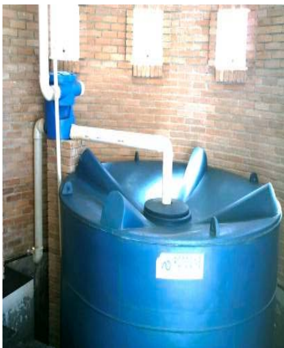
Figura 12. Cisterna no subsolo Fonte: TOMAZ, 2003, p.133
