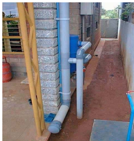
Figura 11. Tubos condutores que levam a água da chuva até a cisterna Fonte: CAMPOS, 2004, p. 89
