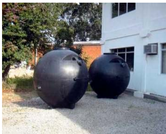
Figura 15. Cisterna apoiada Fonte: MAY, 2004, p. 49
