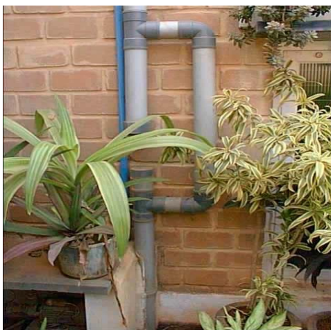
Figura 11. Tubos condutores que levam a água da chuva até a cisterna Fonte: CAMPOS, 2004, p. 89
