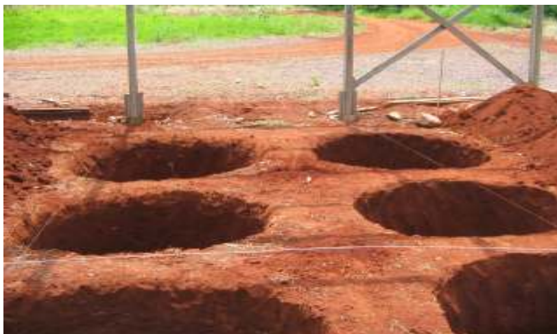
Figura 06 Corte do solo para posteriormente acondicionar as caixas de fibras.
