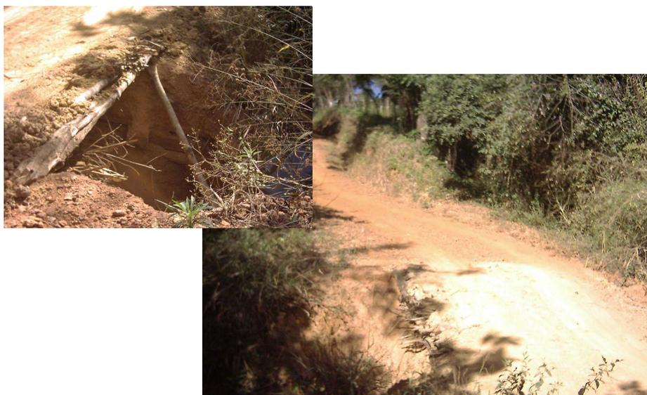
**Figura 18** – Ponte improvisada, no córrego Bonito; observar a terra solta que, no período chuvoso, é carregada para o corpo d'água.
