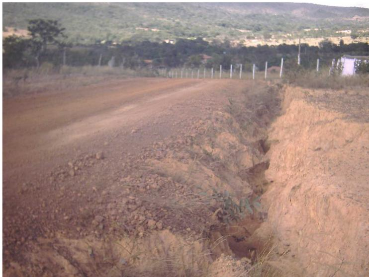
**Figura 17** – Vista de voçoroca, em período seco, escavada por enxurrada, na lateral de estrada, Alto Pacuí, Montes Claros, MG.
