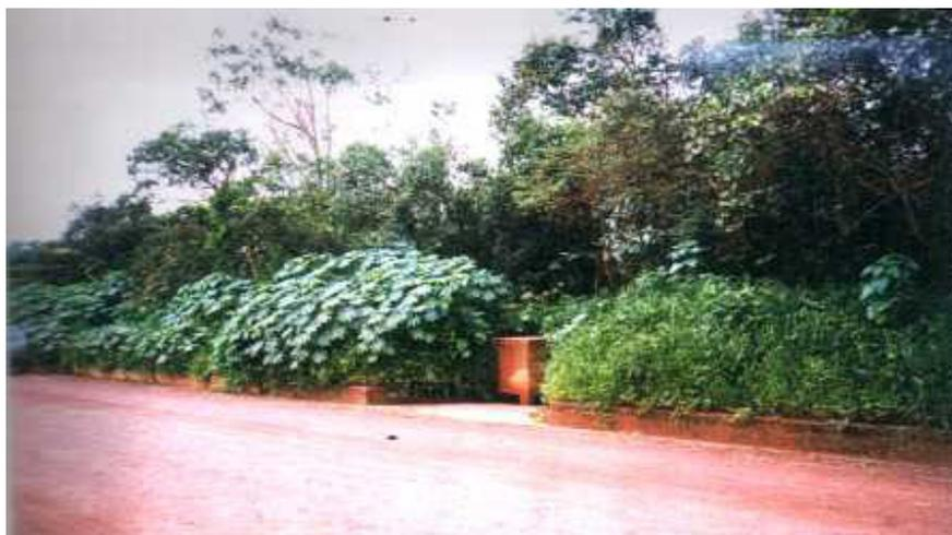
**Figura 21** – Estrada de acesso à Somai Nordeste S/A, Alto Pacuí, Montes Claros, MG; notar as calhas para recolhimento da água das chuvas e o local apropriado para o deságüe.
