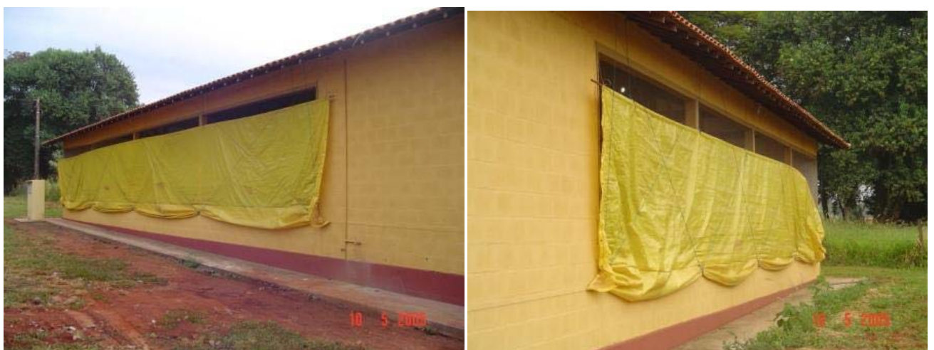
Figura 5 – Galpão do experimento, dando destaque para as cortinas nas aberturas laterais
