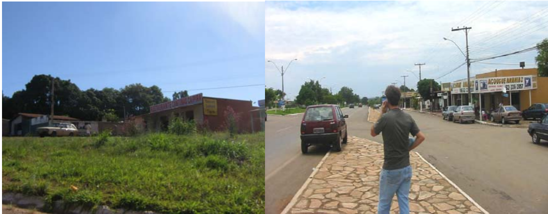
Fig. 13 – Áreas desocupadas e segurança frágil junto a BR-060 e a Avenida marginal. Fontes: Acervo do Autor, 2007 e Plano Diretor de Alexânia, 2005.
