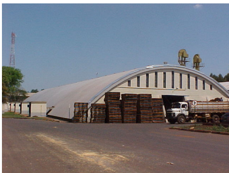
T3 – Armazém “climatizado”
