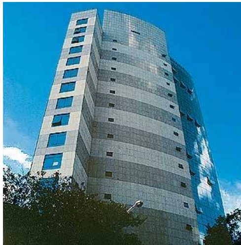
Figura 80: Edifício em Belo Horizonte revestido com placas de granito Fonte: Finestra (2003)
