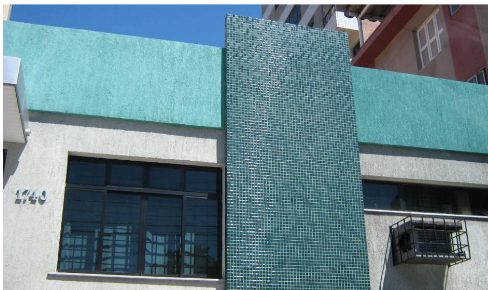
Figura 78: Detalhe de pastilha de vidro usada em fachada Fonte: Autor
