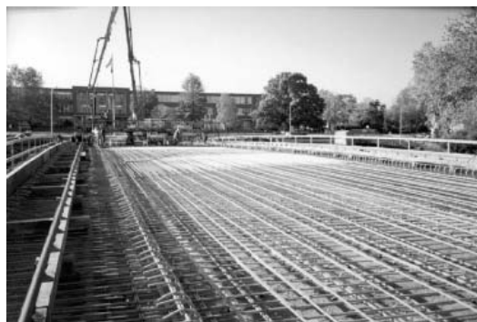
Figura 1.5 – Construção de ponte em Lima – Ohio (ACI 440 1R, 2003)
