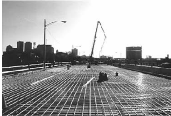
Figura 1.6 – Reabilitação do tabuleiro de ponte em Dayton - Ohio (ACI 440 1R, 2003)
