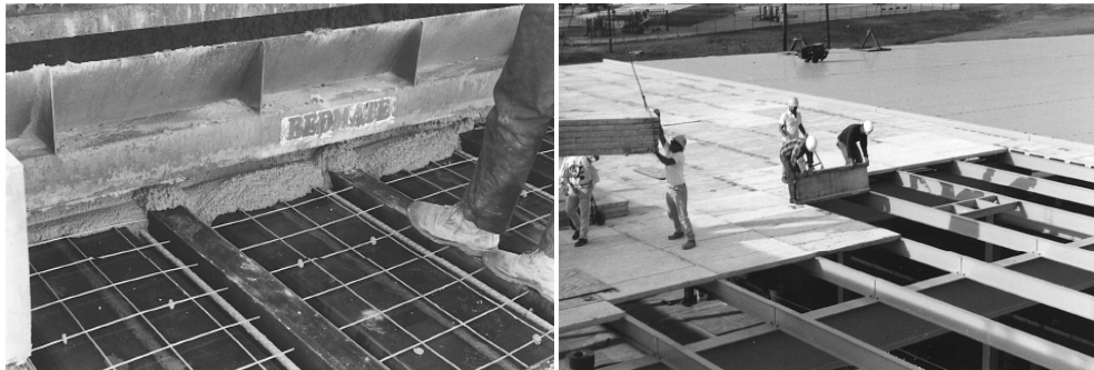
Figura 1.4 – Construção e execução de lajes pré-moldadas na Geórgia (ACI 440 R, 1996)
