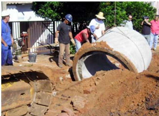
A nova galeria vai substituir a antiga destruída pelas chuvas dos últimos anos
