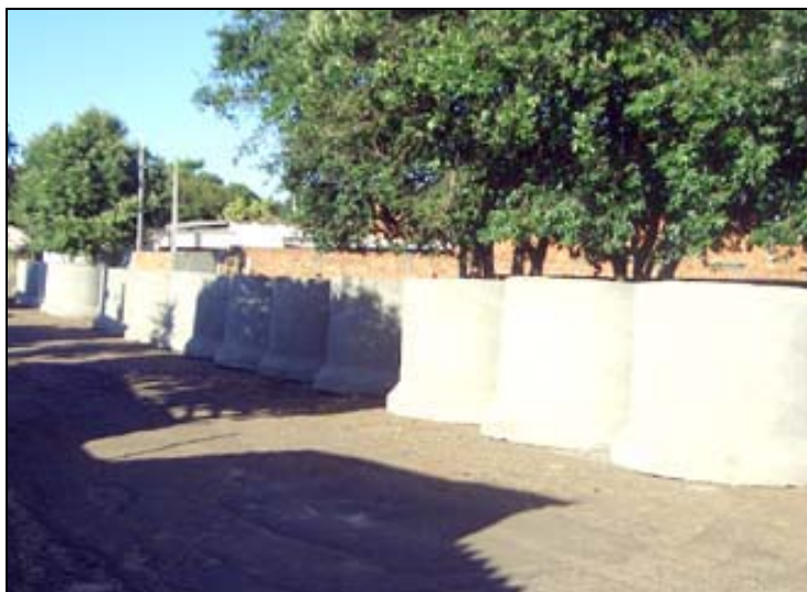
Foto 5: Obras de Melhoria da Infra-Estrutura na Rua Goiás.
