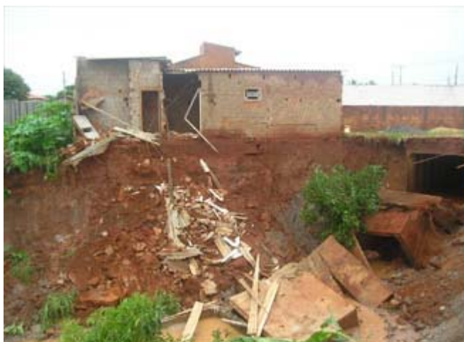
As fortes chuvas, que em dezembro foram além do esperado, provocaram uma grande erosão que atingiu as residências
