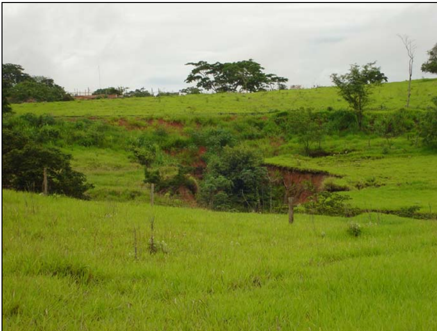
Foto 26: Vista Parcial dos Processos Erosivos Identificados na Área Verde Permanente do Loteamento Big Plaza
