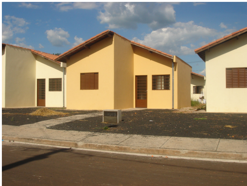
Figura 16 - Casa de arrendatário, localizada na rua Samuel Faria dos Santos nº 68, antiga rua 2, em fevereiro de 2.006, antes das reformas.
