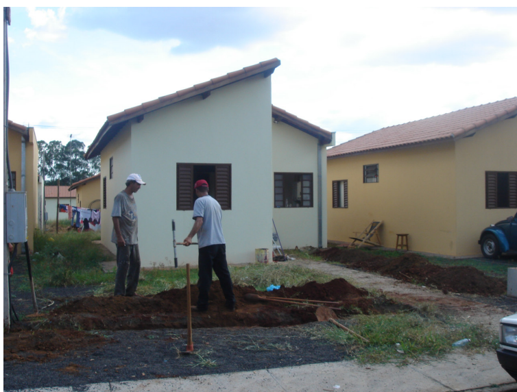
Figura 15 - Casa de arrendatário, localizada na rua Vivaldo Princesa nº 1.016, antiga rua 7, no início dos obras de reforma.
