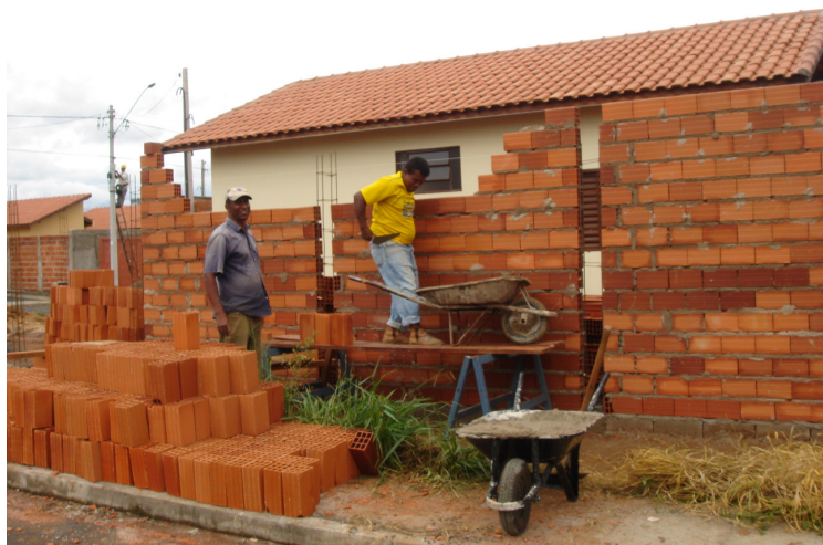
Figura 7 – Construção de muro divisório em casa de esquina do residencial.
