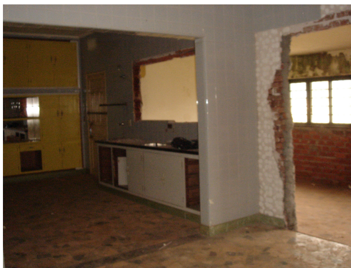
Figura 9 - Vista interna da futura sede do Núcleo de Atendimento à Criança e ao Adolescente durante a reforma.
