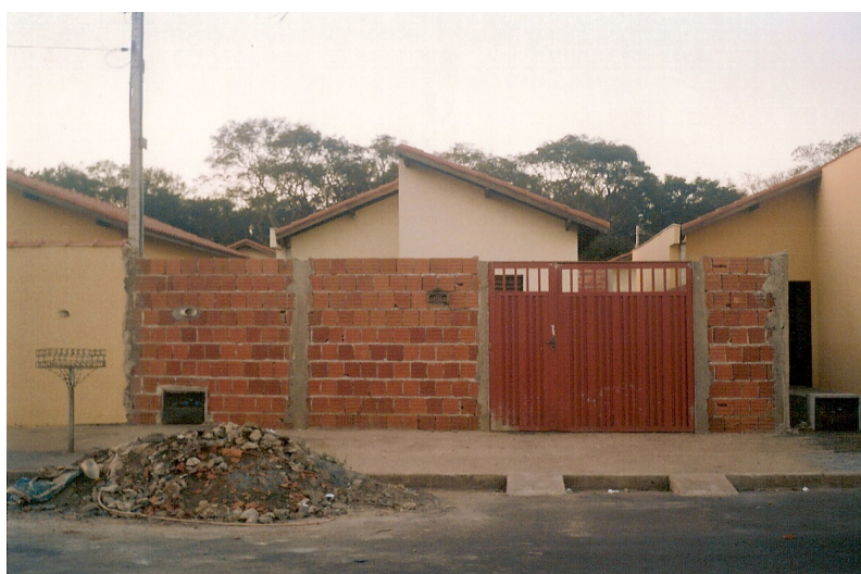
Figura 13 - Casa de arrendatário, localizada na rua Jornalista Eduardo Librandi , nº 1.105, antiga rua 8, durante das reformas.
