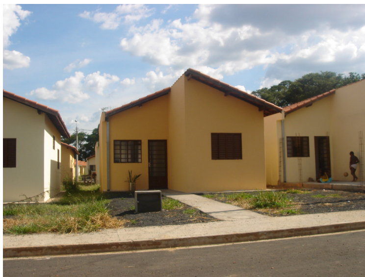
Figura 14 - Casa de arrendatário, localizada na rua Domingos Canesin nº 76, antiga rua 14, antes da reforma na qual ele a murou, colocou portão e trocou revestimentos internos.
