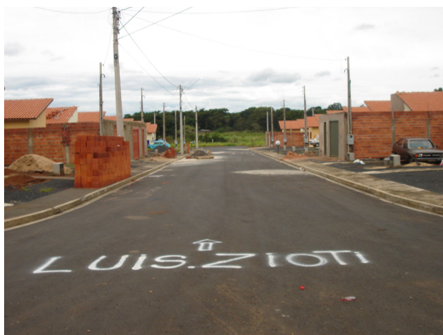
Figura 20 - Rua Luis Zioti com sinalização no asfalto.
