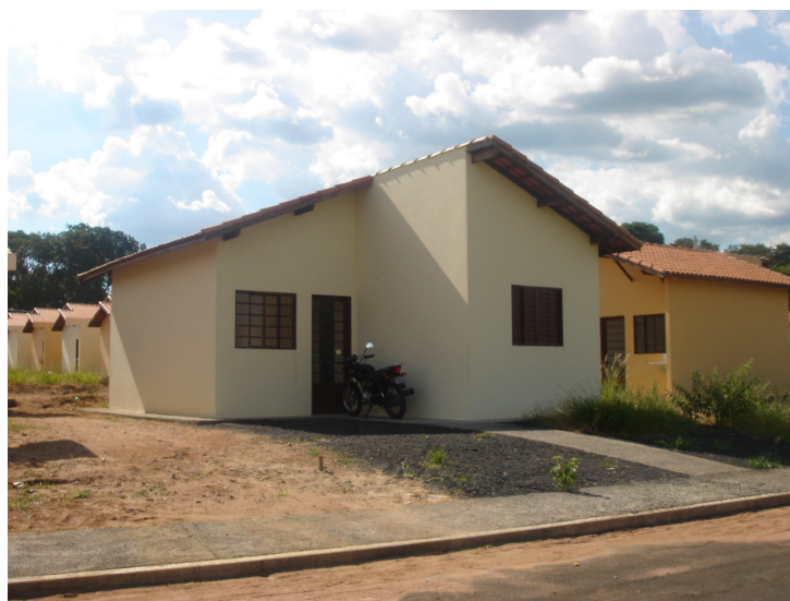
Figura 22 – Em detalhe, a área de serviço das casas do Leo Gomes.
