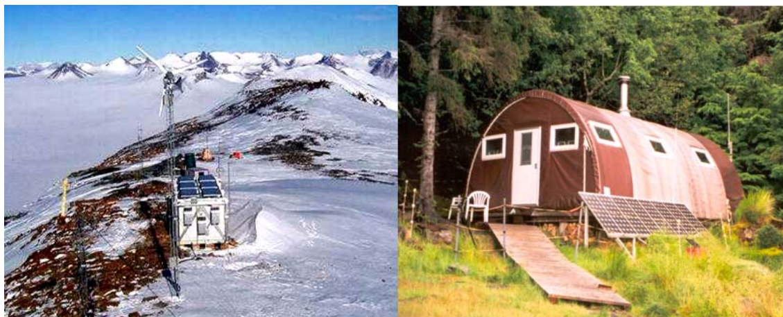
Figura 1.3. Sistemas fotovoltaicos utilizados em localidades remotas
