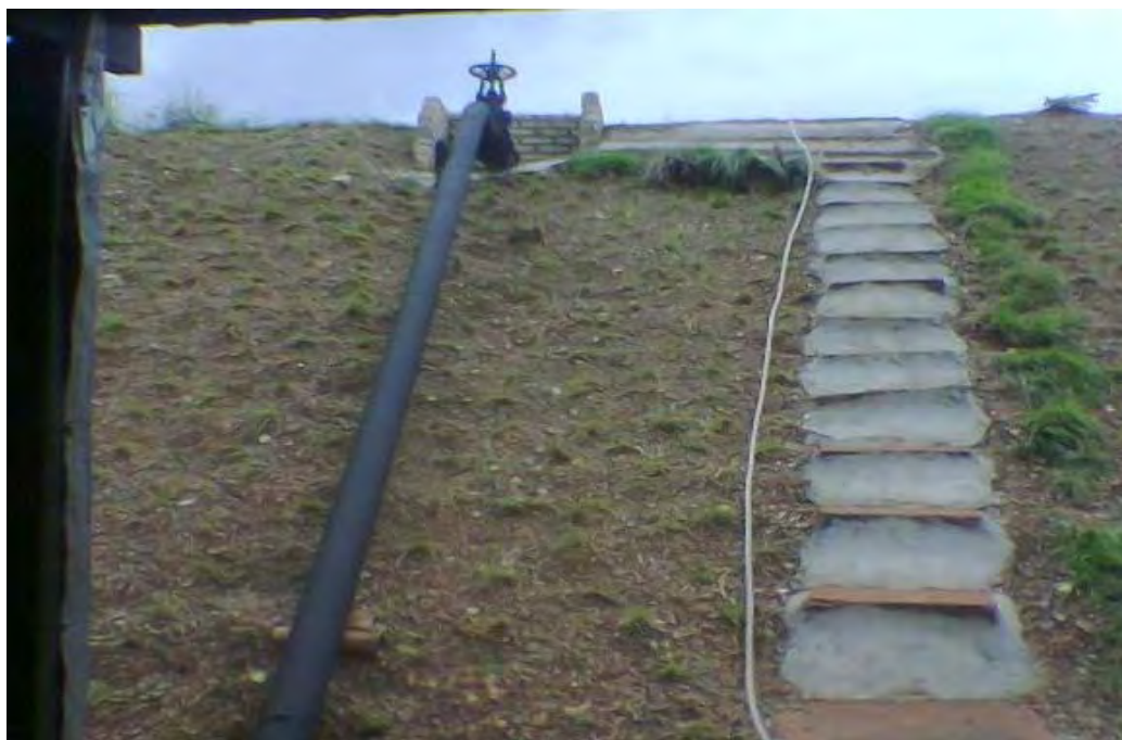
Figura 18 – Protótipo – Estância Cocalinho – Tubulação de queda.
