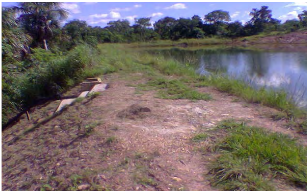
Figura 21 – Protótipo Estância Cocalinho: Represa e tomada d'água.
