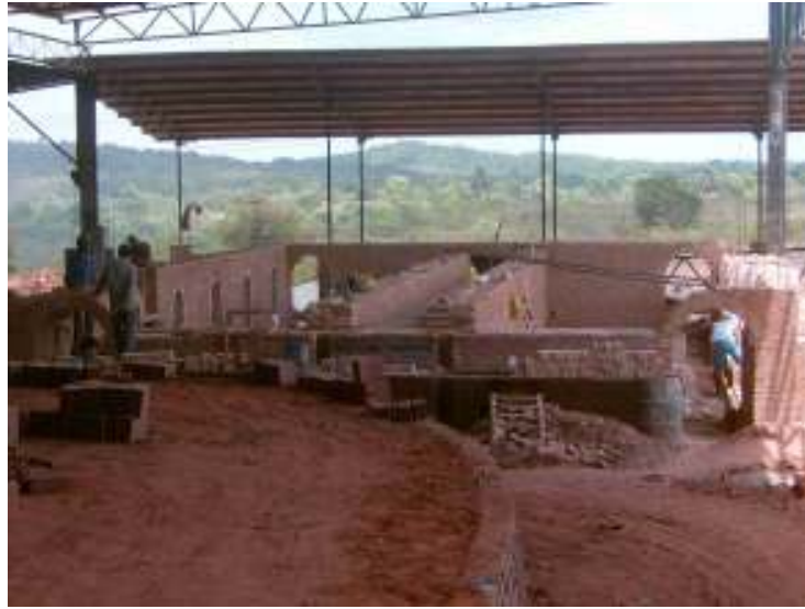
Figura 2.11 Forno tipo contínuo em fase de construção
