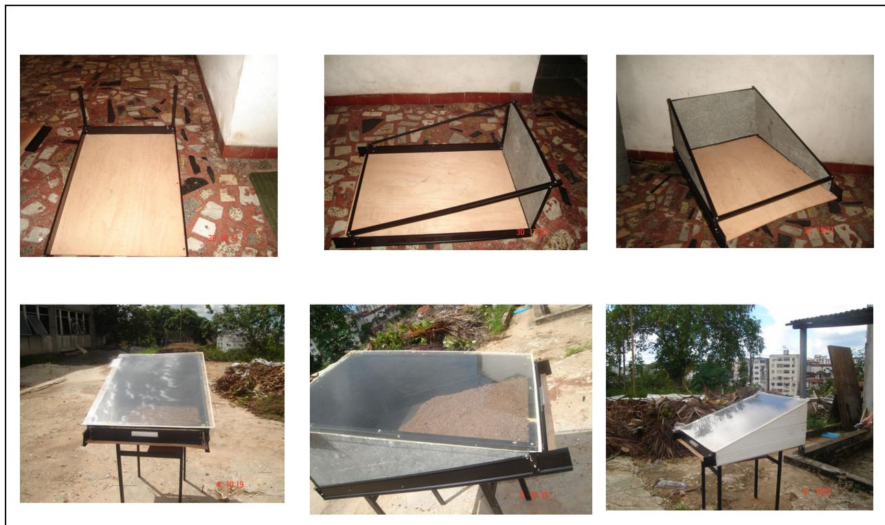
**Figura 4.2:** Fotos das etapas de construção do secador de exposição direta
