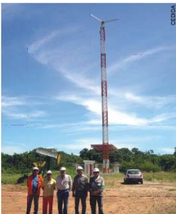
Figura 03: Sistema híbrido eólico-solar (PETROBRAS, 2007)
