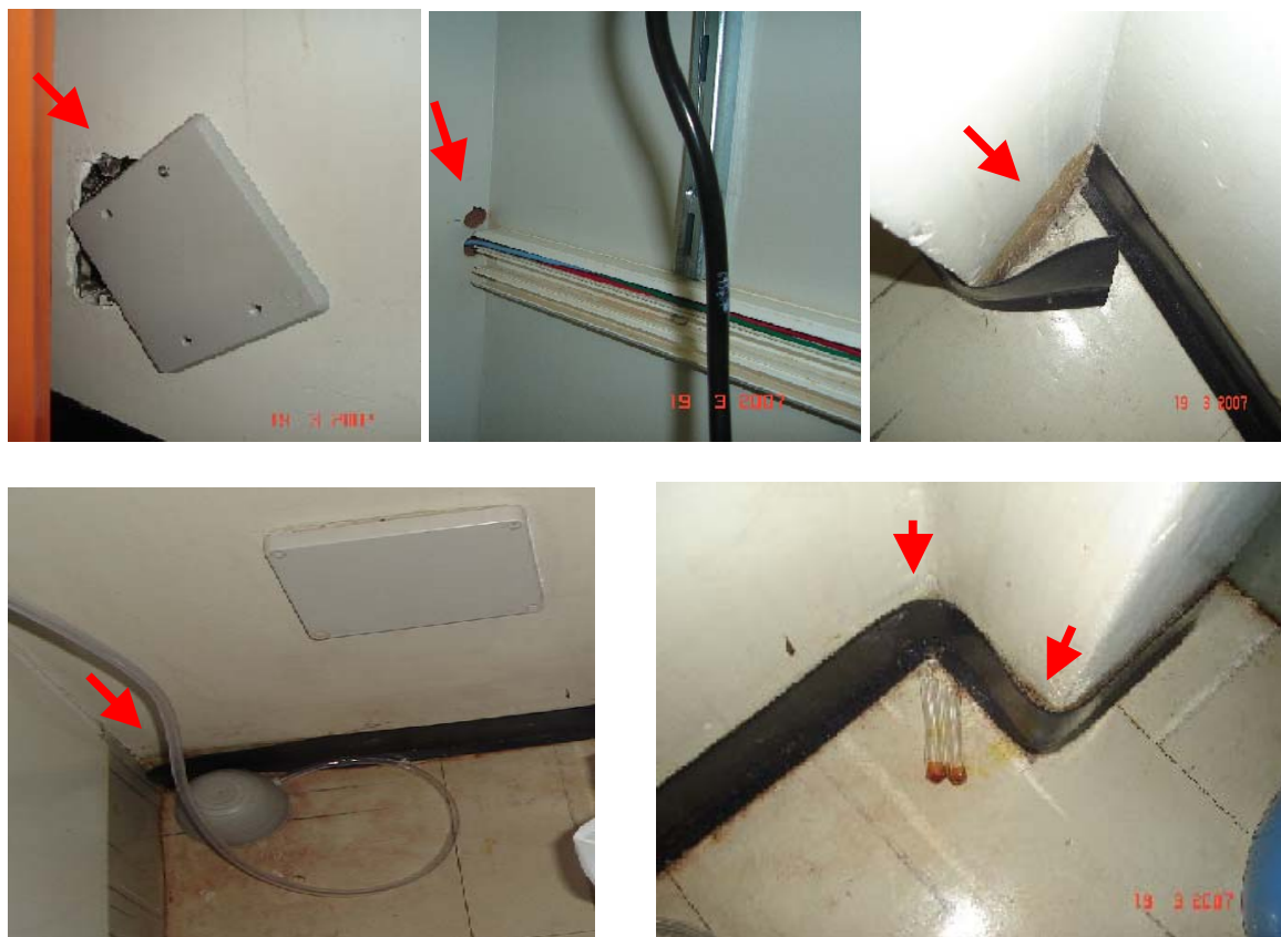
Figura 9. Fotos das UTIs geral e pediátrica do Hospital Escola da UFTM, demonstrando locais que facilitam construções de ninhos de formigas.
