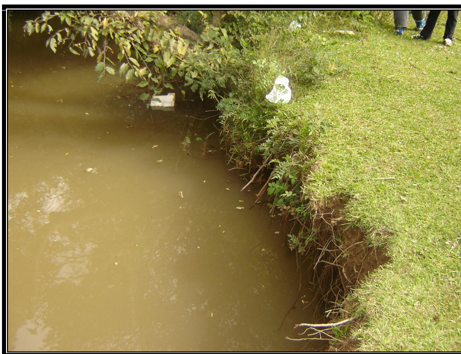
Figura 16: Erosão das margens do Lajeado Data: 12/05/2006
