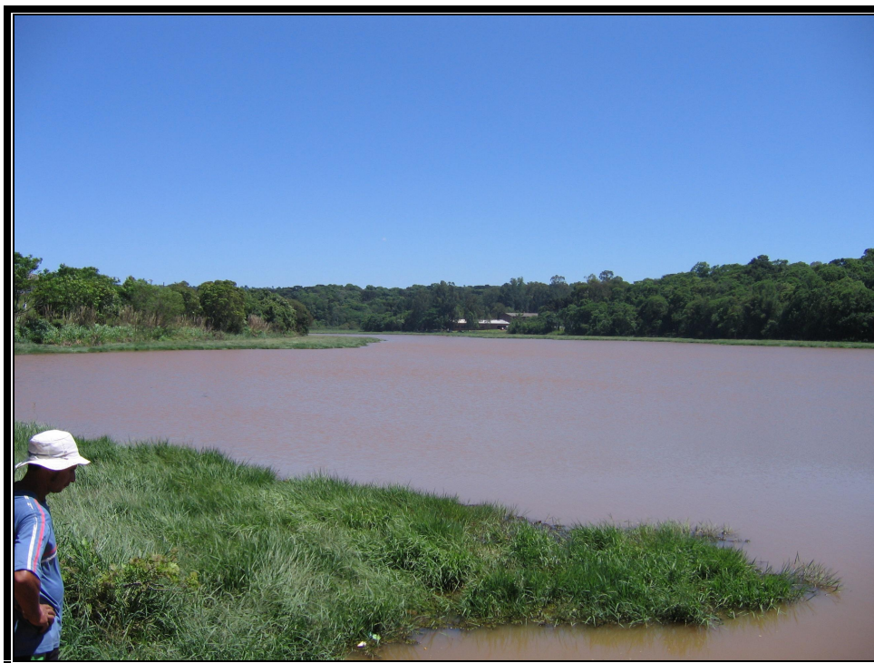
Figura 20: Barragem de captação da água Data: 15/06/2006
