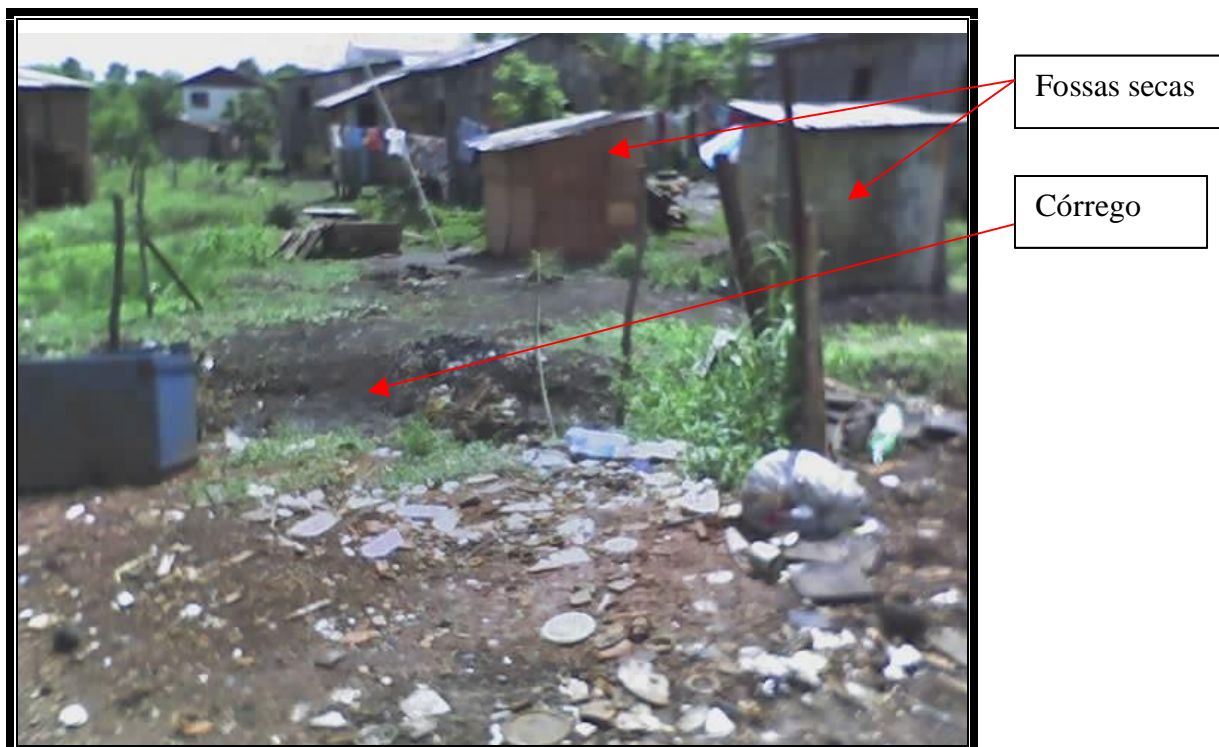
Figura 25: Fossas rudimentares próximas ao córrego Data: 19/10/2004
