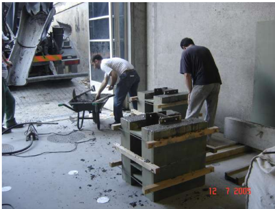
FIGURA 3.53 – Concretagem dos modelos X1 e X2 no LEST/UM.
