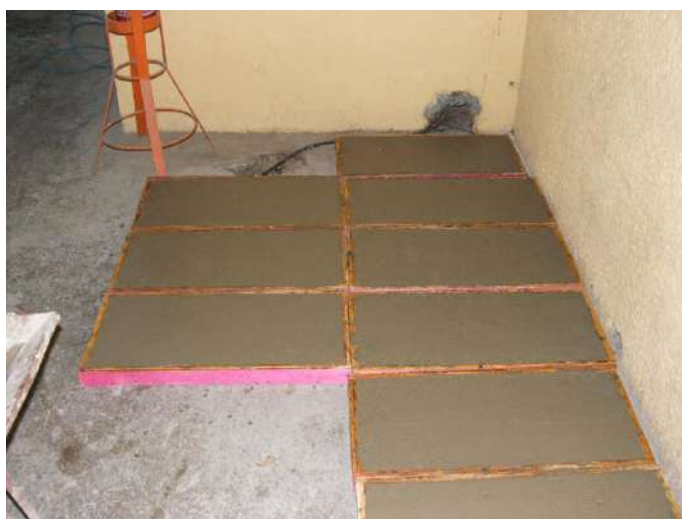
FIGURA 3.86 – Produção das pré-lajes - série D.
