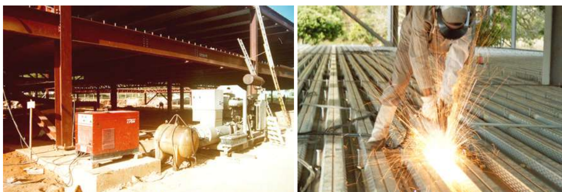
FIGURA 2.7 - Sistema para soldagem de conectores stud (fotos do autor).
