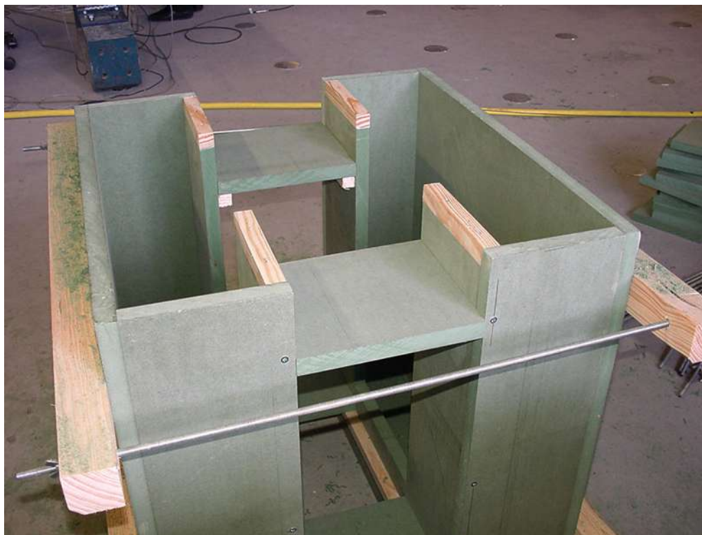
FIGURA 3.8 – Aspecto da fôrma montada.
