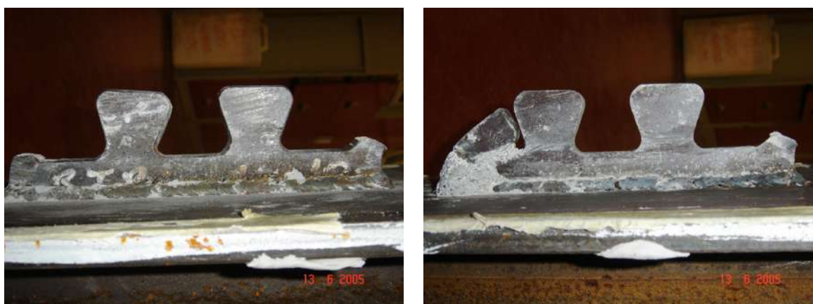
FIGURA 3.32 – Estado dos conectores do modelo A1 ao final do ensaio.
