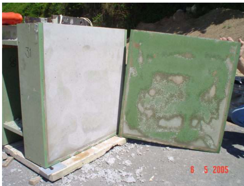
FIGURA 3.23 – Aspecto do concreto e da fôrma após desmoldagem (fôrma de MDF hidrófugo com verniz selador e desmoldante da SIKA).
