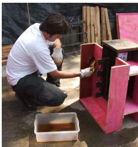
FIGURA 3.84 – Aplicação de desmoldante nas fôrmas - série D.
