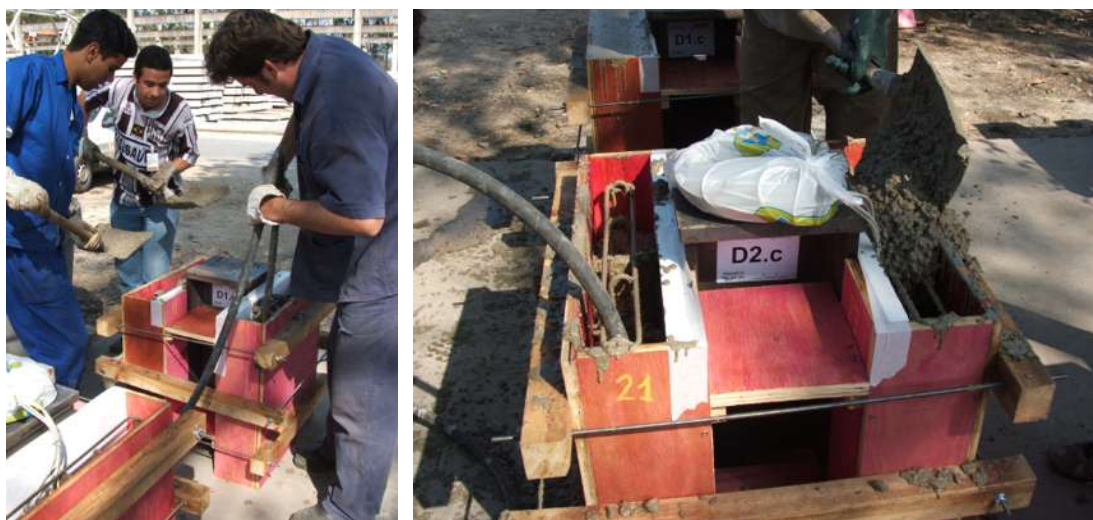
FIGURA 3.90 – Lançamento e vibração do concreto das lajes – série D.
