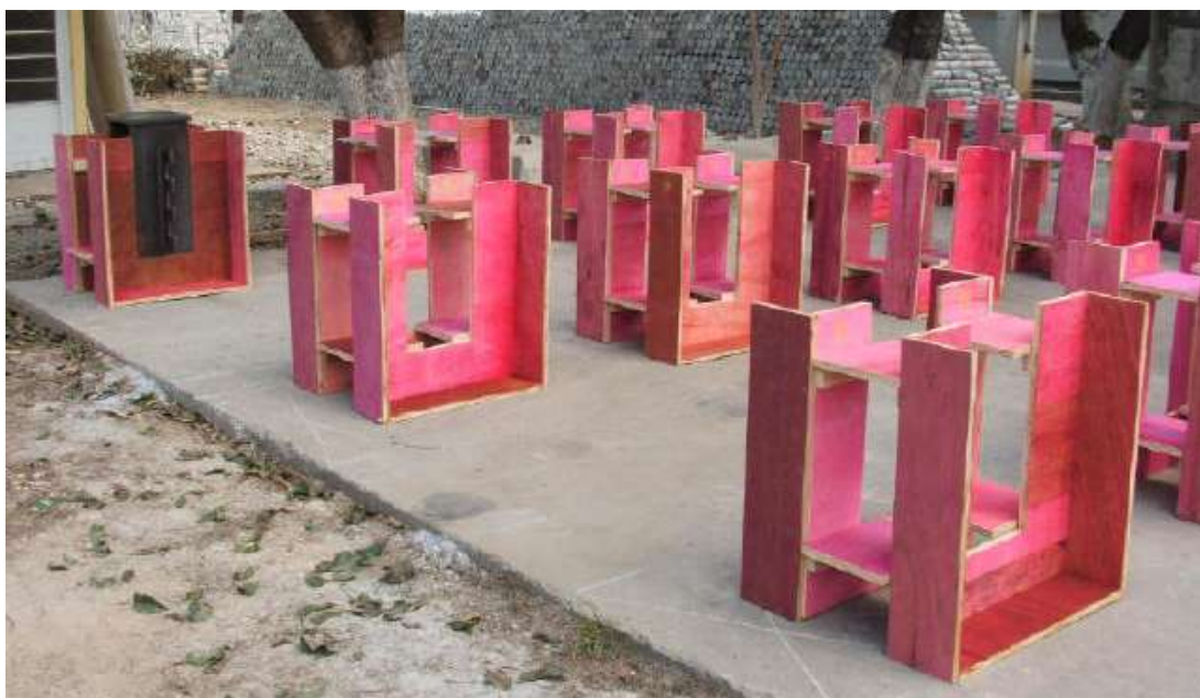
FIGURA 3.83 – Montagem das fôrmas - série D.
