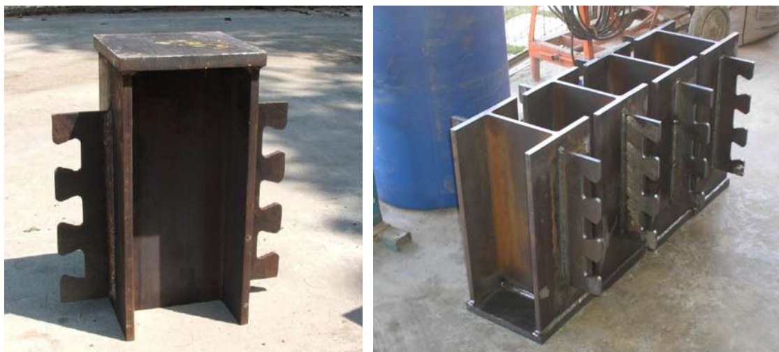
FIGURA 3.80 – Perfis com os conectores CR56b-PL para a série D.
