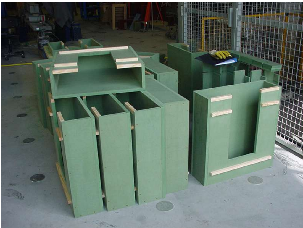
FIGURA 3.7 – Aspecto das fôrmas para as lajes.
