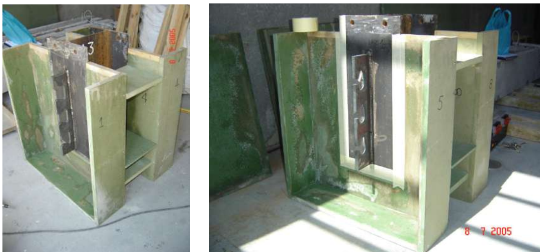
FIGURA 3.51 – Montagem dos modelos X1 e X2 – colocação dos perfis na fôrmas.
