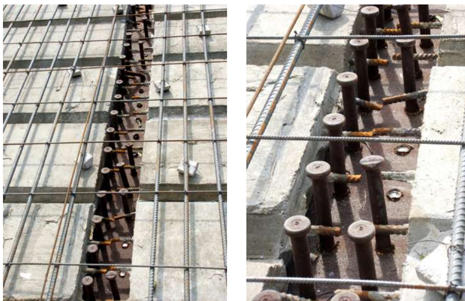
FIGURA 2.6 – Problemas na solda de conectores stud (foto do autor).
