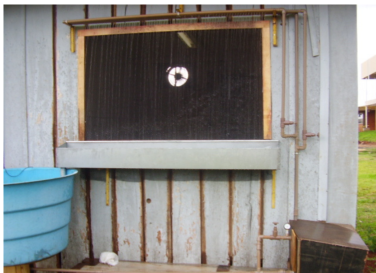
Figura 10 - Vista frontal da instalação do dispositivo.
