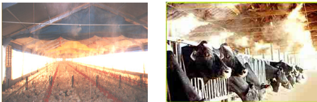
Figura 3 - Galpões com instalação de nebulizadores.
