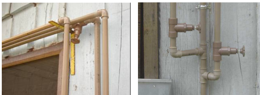
Figura 22 - Condutores de distribuição de água e registros.
