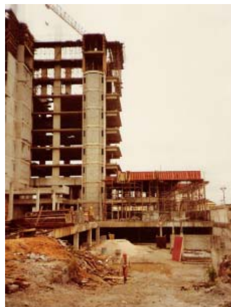
Figura 70 - As torres de serviço em construção. Fonte: Arquivo pessoal dos arquitetos.
