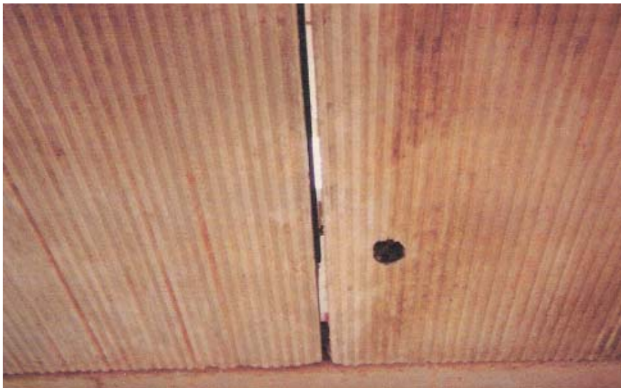
Figura 63 - Laje pré-moldada - Fonte: Arquivo pessoal dos arquitetos.
