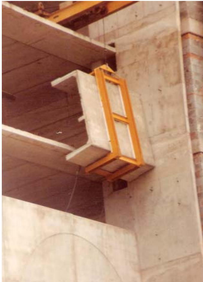
Figura 61- Caixa Lateral pré-moldada em montagem - Fonte: Arquivo pessoal dos arquitetos.
