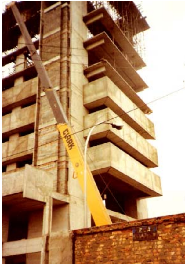
Figura 72 - Execução das torres laterais e das caixas pré-moldadas - Fonte: Arquivo pessoal dos arquitetos.
