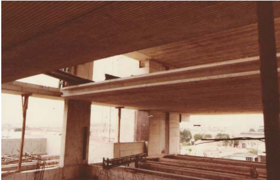
Figura 62 - Laje pré-moldada em execução - Fonte: Arquivo pessoal dos arquitetos.
