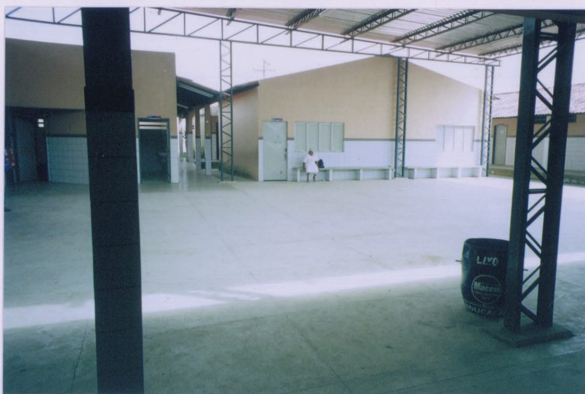
FIGURA B – Visão de entrada do pátio central – Escola B
