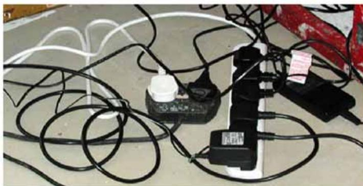
**Figura A-4** Instalação elétrica desorganizada com possibilidades de acidentes.
