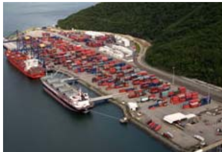
FIGURA 3.27 – Vista parcial do porto de Sepetiba. Fonte: TECON Sepetiba (2007)
