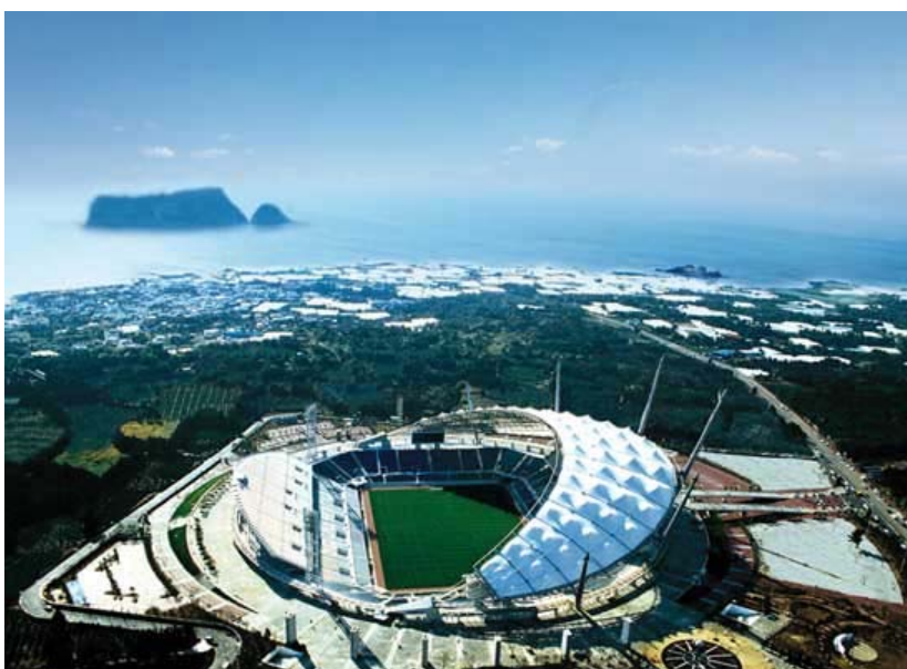
Figura 1.8 - Estádio de Jeju, Coréia (2001) - Com formas representativas da cultura local, lembrando as atividades pesqueiras, vulcões e as estruturas residenciais em madeira entrelaçada, este estádio segue as tendências contemporâneas de ecletismo aliado a símbolos subliminares utilizando como estrutura de sua cobertura sistemas de forma-ativa, vetor-ativo e superfície-ativa.
