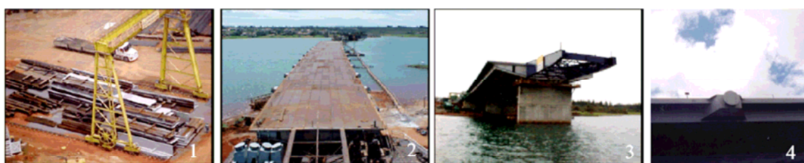
Figura 4.2.5 – (1) Ponte rolante no canteiro de obras. (2) Vista aérea da pista. (3) Peça para ancoragem das seções da mesa. (4) Arranque de ancoragem do cabo à pista.
