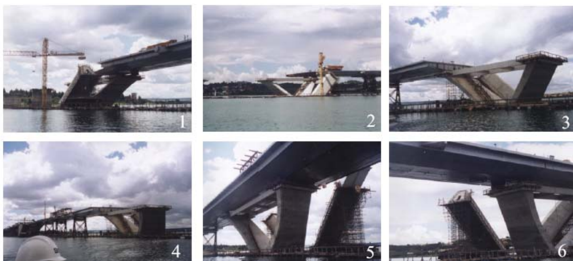
Figura 4.2.4 – (1,2) Base em concreto sendo construída. (3,4) Mesa para apoio das pistas independentes. (5,6) Apoio das pistas ainda sobre escoras.
