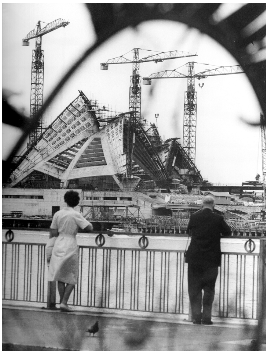
Figura 4.3.4 – Foto da Opera em construção – Com os centros rígidos já prontos os arcos com seções pré-moldadas foram assentados sucessivamente com o auxílio de um andaime pivotante, eliminando a necessidade de um escoramento mais denso.
