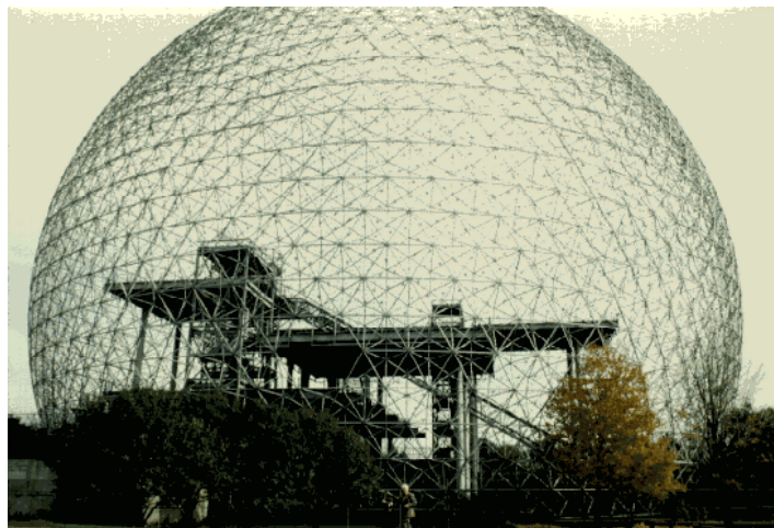
Figura 1.4 - Pavilhão Norte-Americano da Exposição Mundial de 1967 - Com a Geodésica, Buckminster Fuller aprimorou e difundiu o conceito de vetor-ativo. Com estudos aprofundados sobre sinérgica, nome dado ao seu estudo de dinâmica estrutural, Fuller conseguiu desenvolver de maneira definitiva os processos produtivos e executivos das treliças espaciais.
