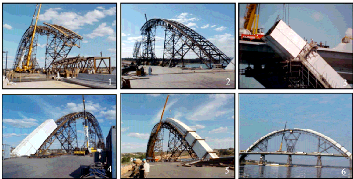
Figura 4.2.6 – (1,2) Andaimos para apoio dos arcos na fase de execução. (3) Ancoragem da parte metálica do arco à base de concreto. (4,5,6) Assentamento das seções do arco.
