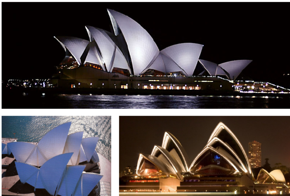
Figura 4.3.1 – Opera de Sydney – O desenvolvimento natural destas formas sobre as águas da baía trouxeram a este edifício uma condição única de signo, nenhum outro edifício em concreto atingiu de maneira tão veemente o objetivo proposto.
