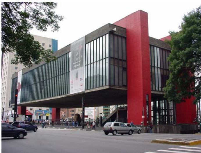
Figura 1.5 - MASP – Com uma proposta mais ousada do que a arquitetura executada em sua época, 1947, o Museu de Arte de São Paulo utiliza diversas tecnologias para aliar uma linha modernista, típica nas estruturas de seção-ativa, a uma estética desafiadora muito usual em monumentos contemporâneos.
