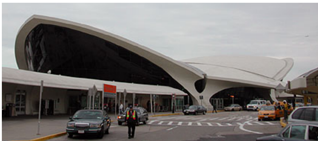
Figura 1.6 - Terminal TWA, Aeroporto JFK, Nova York. – Estrutura executada em um sistema de superfície-ativa que representa muito bem quão plástico e funcional pode ser a utilização do concreto armado. A distribuição suave das cargas através das estruturas curvas possibilita melhor trabalho do fluxo de forças em sua descarga no solo e conseqüentemente possibilitam uma estética mais aprimorada e um programa melhor resolvido da arquitetura.
