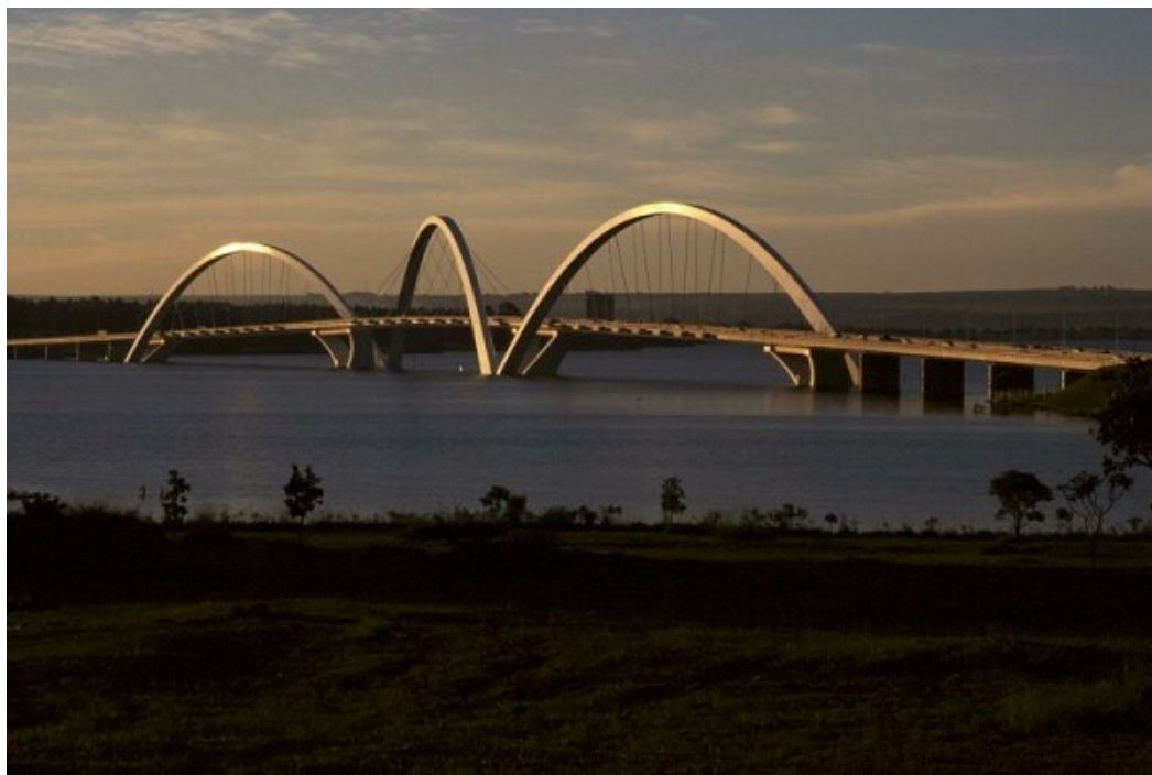
Figura 4.2.1 – Ponte JK – Imagem de todo conjunto revelando a sutileza e a limpeza estética que se contrapõe à extrema complexidade dos fluxos de força.
