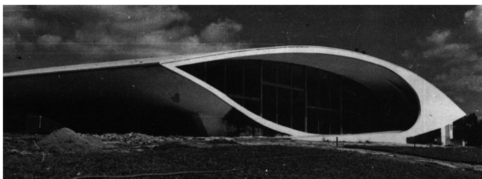
Figura 4.1.1 – Cobertura para o Auditório de um Colégio Estadual, 1954, Belo Horizonte – Um dos grandes exemplos da curva no trabalho de Niemeyer. Proporção, sutileza e continuidade fazem desta cobertura em superfície-ativa um bom exemplo da plasticidade buscada e obtida pelo arquiteto utilizando o concreto armado.
