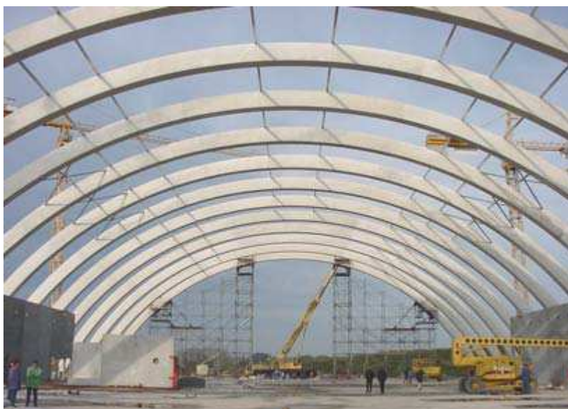
Figura 4: arcos compostos por cinco peças executadas em CAA (Fonte: Walraven, 2005)
