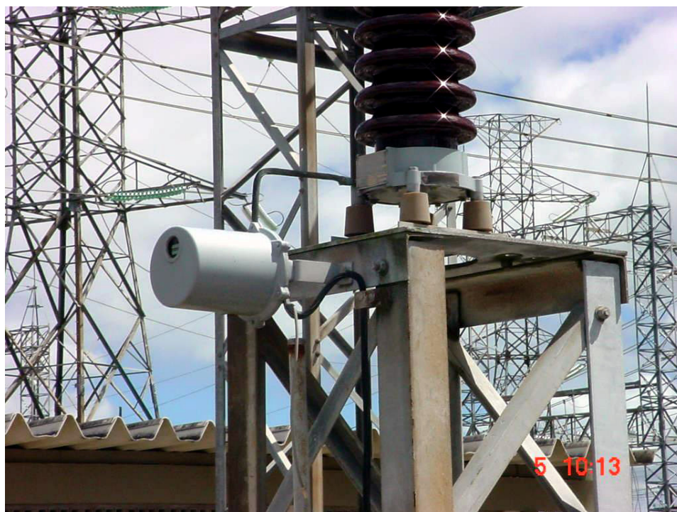
Figura 5.5.2 – Base do Pára-Raios de ZnO.
