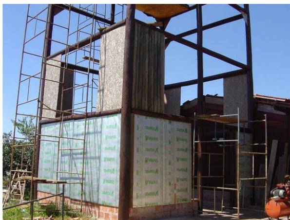
Figura 7.15 – Montagem dos painéis do edifício experimental.
