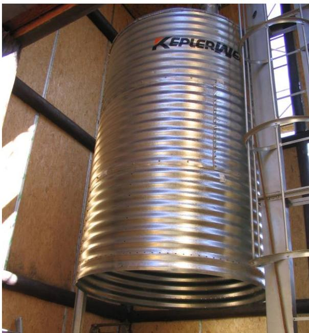
Figura 7.22 – Içamento do corpo do silo de armazenamento.
