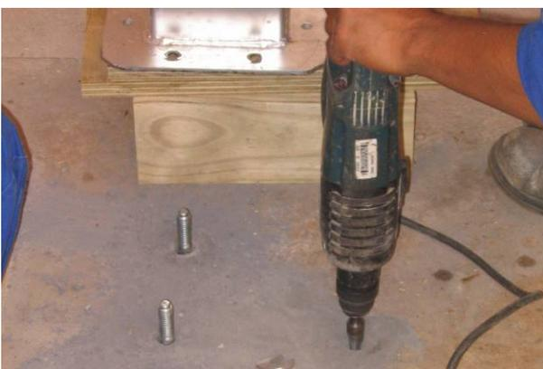
Figura 7.20 – Colocação de chumbadores para a fixação dos montantes da laje de apoio.
