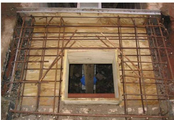
Figura 7.18 – Montagem parcial das armaduras da laje.
