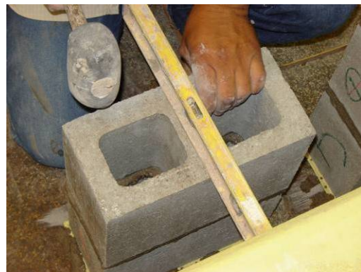
Figura 30 – Nivelamento da segunda fiada com auxílio de nível de bolha e martelo de borracha.
