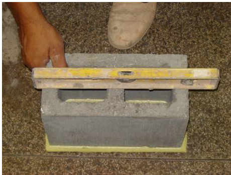
a) nivelamento do bloco inferior
