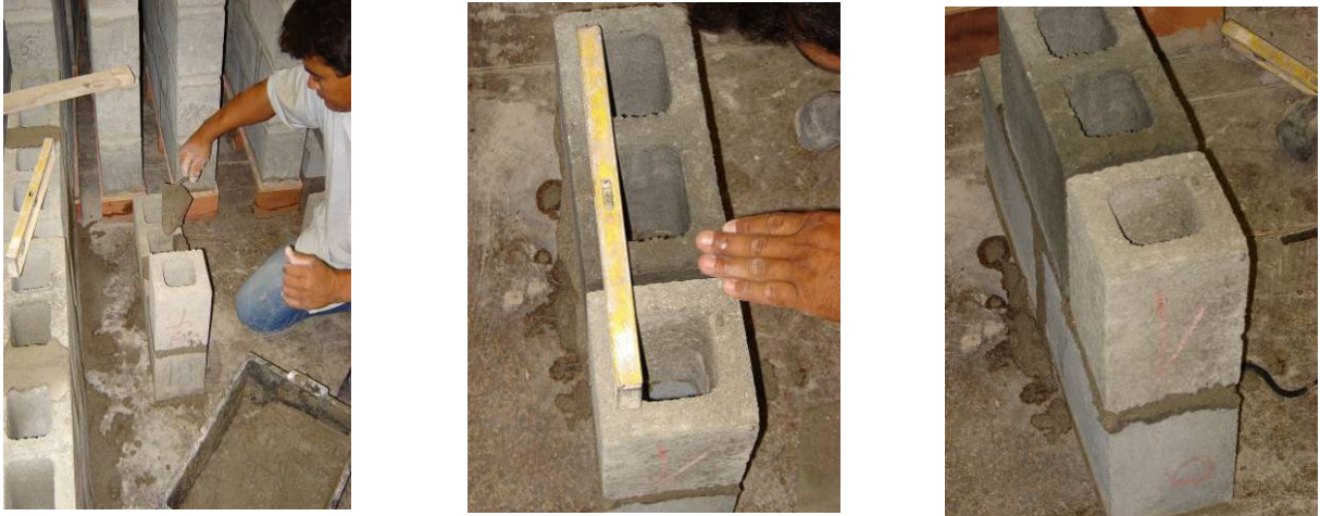
Figura 37 – Execução da segunda fiada.
