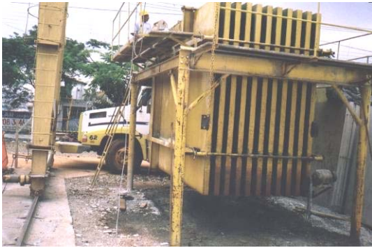
a) fôrmas metálicas para os painéis
