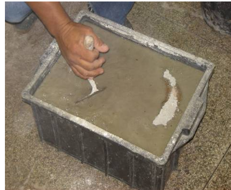
b) adição gradual da água até a obtenção da consistência adequada
