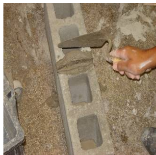
b) execução da junta vertical de argamassa
