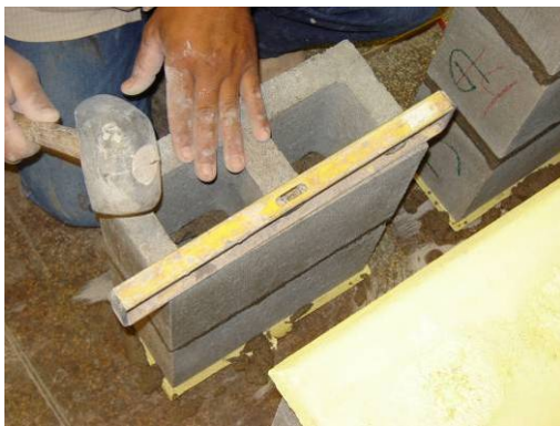
Figura 30 – Nivelamento da segunda fiada com auxílio de nível de bolha e martelo de borracha.
