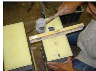
c) nivelamento da unidade superior
