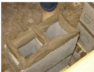
a) aplicação da segunda junta de argamassa
