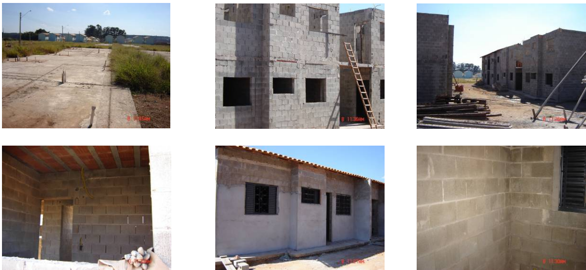
Figura 2.10 – Casas construídas com blocos de agregados reciclados (foto do autor).
