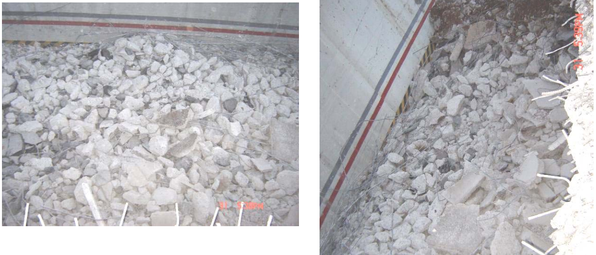
Figura 2.4 – Demolição de viaduto na rodovia Washington Luís (km 235) (foto do autor).
