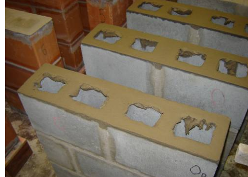
Figura 39 – Nivelamento da face superior com argamassa de cimento e areia.
