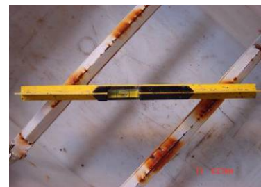
f) nivelamento dos suportes
