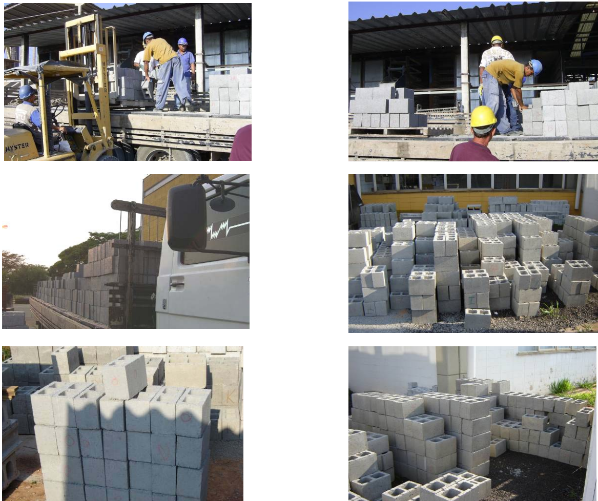
Figura 7.13 – Transporte/estocagem dos blocos.
