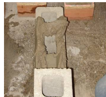
c) disposição dos cordões longitudinais e transversais de argamassa
