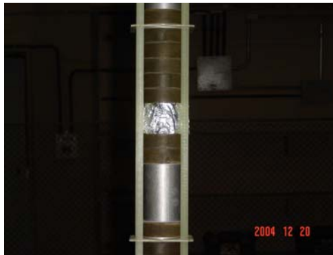
Fig. 56 - Varistores subseqüentes sob curto-circuito.
