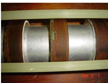
Fig. 35 - Degradação do isolamento lateral.
