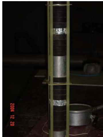
Fig. 50 – Varistores com defeito.
