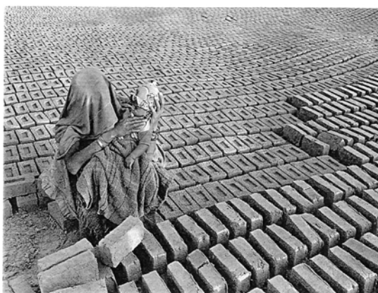
Foto 4 – Índia, Construção do Canal de Irrigação do Rajastão
