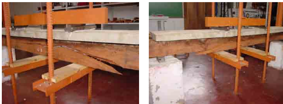
Figura 5.9 – Ruptura nos pontos de aplicação da força na viga 3
