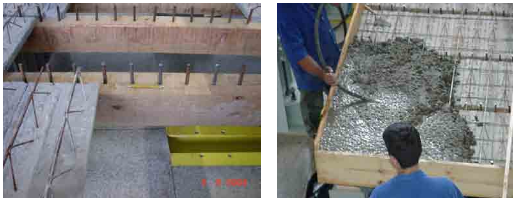
Figura 2.50 - Pinos de cisalhamento, formas laterais e concretagem do modelo experimental.
