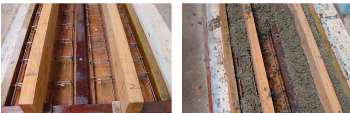
Figura 5.5 – Concretagem das vigas de madeira-concreto
