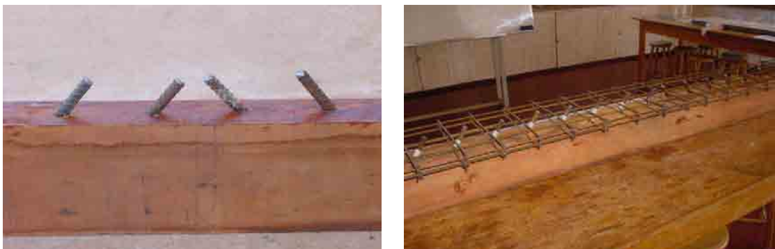
Figura 5.3 – Pinos inclinados e armadura da mesa de concreto
