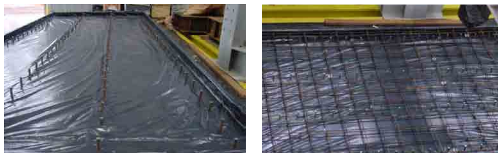
Figura 6.10 – Preparação da forma para concretagem
