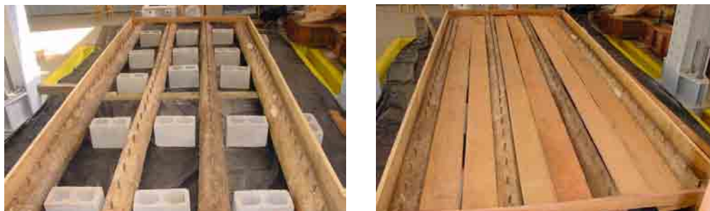
Figura 6.9 – Montagem da forma da laje
