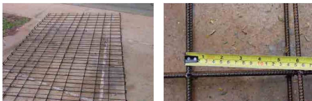
Figura 6.8 – Armadura da laje de concreto
