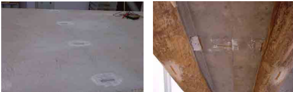
Figura 6.14 – Extensômetros no tabuleiro misto de madeira-concreto
