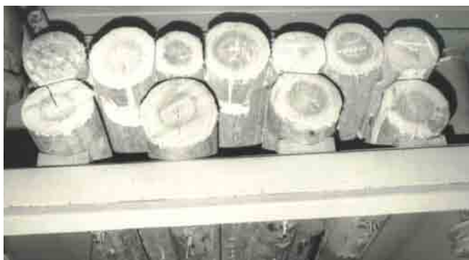
Figura 2.28 – Vigas simples e bi circulares. Fonte: MATTHIESEN (1987)
