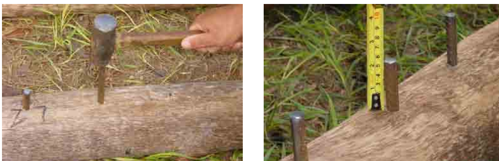
Figura 6.5 – Cravação e verificação da altura de ancoragem
