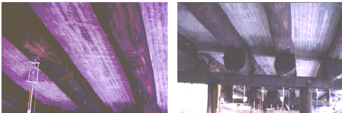
Figura 2.3 – Vigas e consolos de madeira junto com a laje de concreto. Fonte: ROAD AND TRAFFIC AUTHORITY OF NSW (2004)
