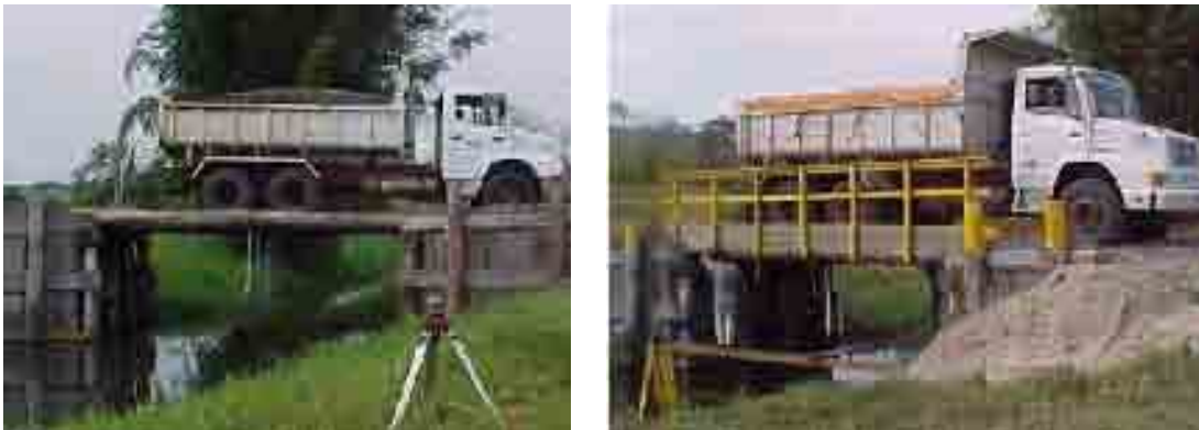
Figura 2.15 – Provas de carga nas vigas e na ponte concluída. Fonte: PIGOZZO (2004)
