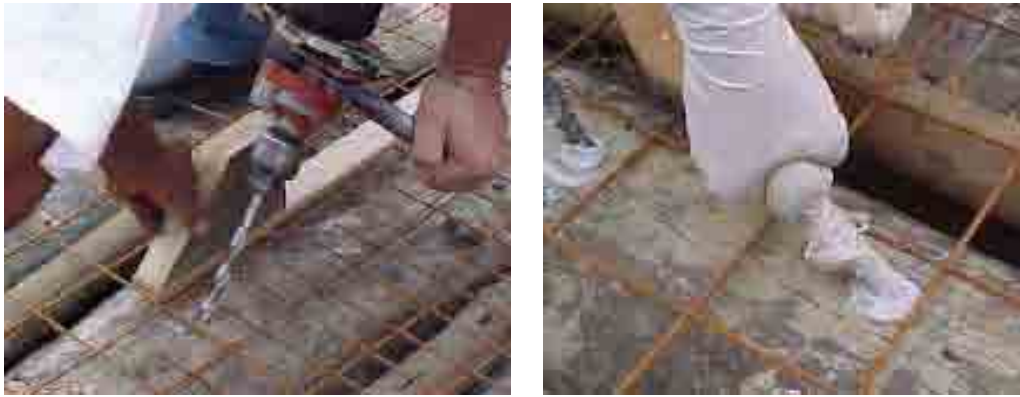
Figura 2.14 – Detalhe da colagem dos conectores. Fonte: PIGOZZO (2004)
