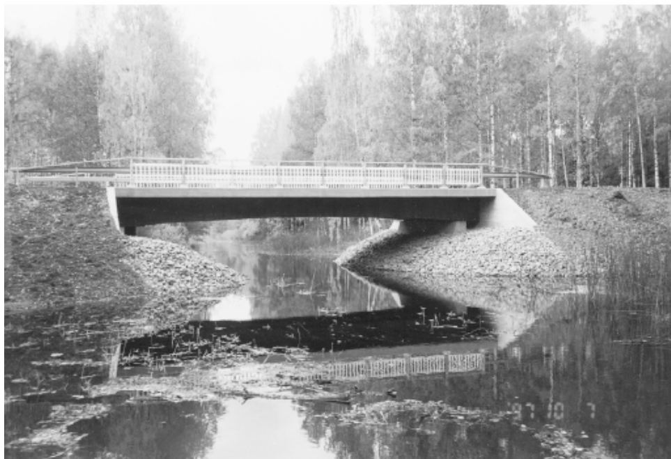
Figura 2.5 – Ponte de madeira-concreto na Finlândia em Tirva, Valkeala. Fonte: FINNRA (1999)
