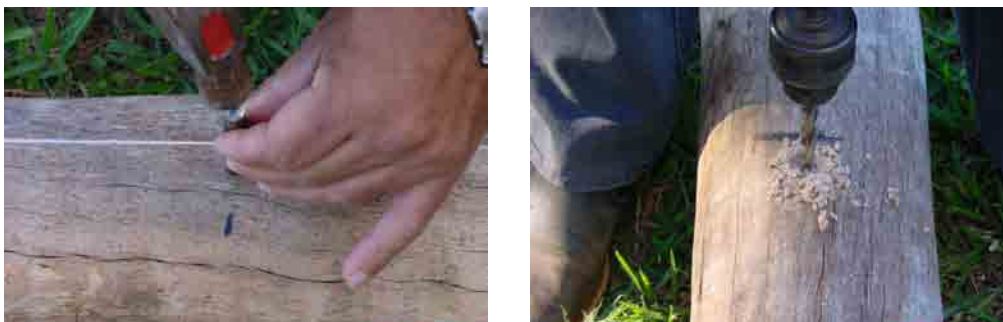
Figura 6.4 – Marcação e pré-furação das vigas de madeira
