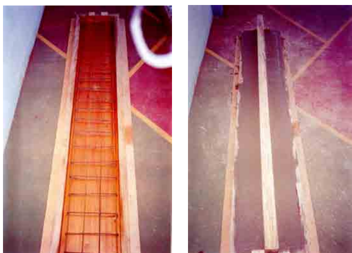
Figura 2.39 – Armadura e viga após a concretagem. Fonte: MATTHIESEN (2001)
