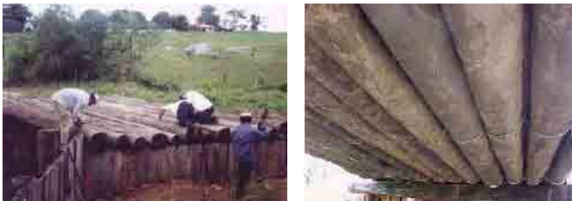
Figura 2.13 – Lançamento das vigas de madeira. Fonte: PIGOZZO (2004)
