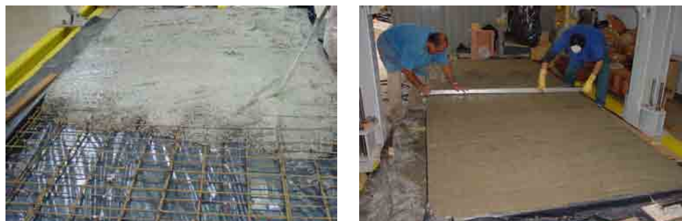
Figura 6.11 – Concretagem e acabamento na laje do tabuleiro misto de madeira-concreto
