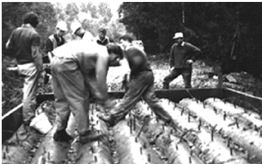
Figura 2.9 – Ponte de madeira-concreto em construção na Forestry, Tasmânia, Austrália.
