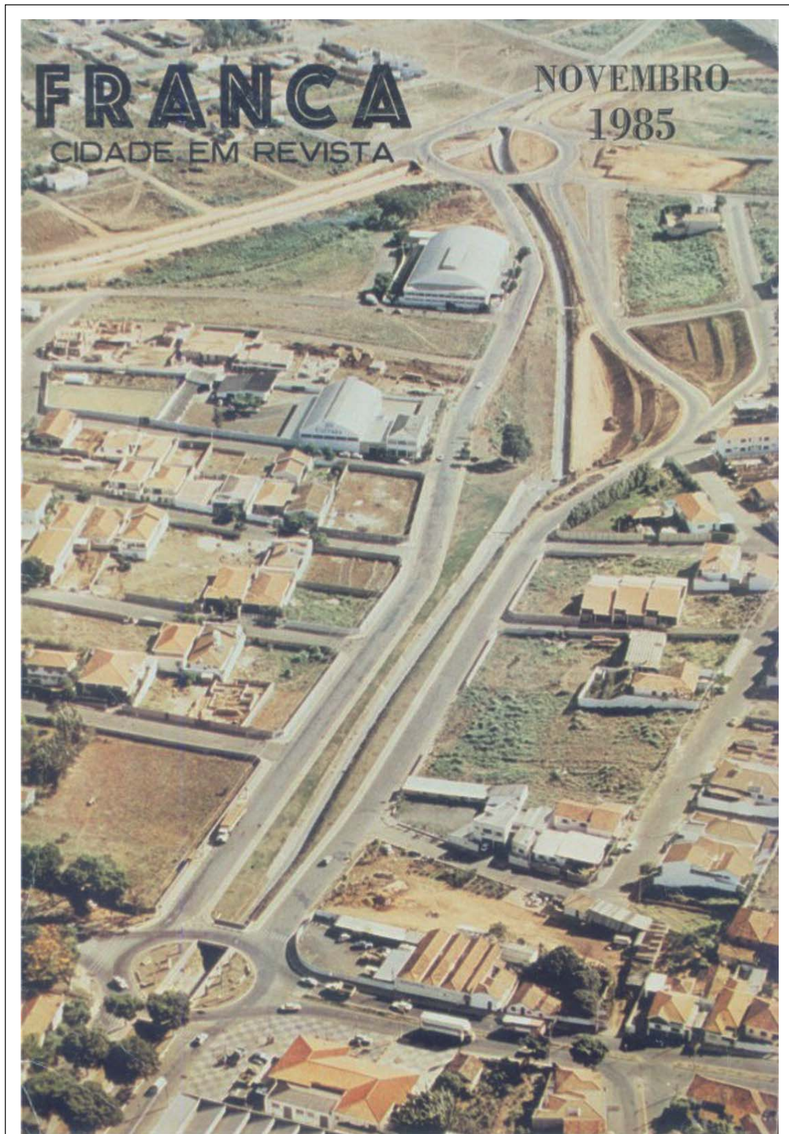
Figura 23. Obras de ampliação da avenida marginal ao córrego do Cubatão e do sistema viário na região
