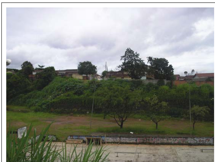
Fonte: Foto do autor, arquivo pessoal Figura 78. Vista atual da voçoroca da Boa Vista, com equipamentos esportivos deteriorados.
