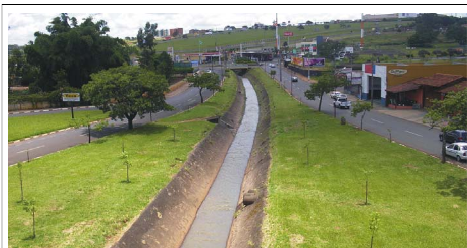
Figura 97. Vista atual da canalização do córrego do Cubatão, no encontro com o córrego dos Bagres.
