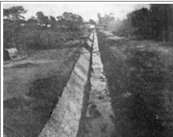
Figura 41. Obras de canalização da Avenida Ismael Alonso nos anos 60.
