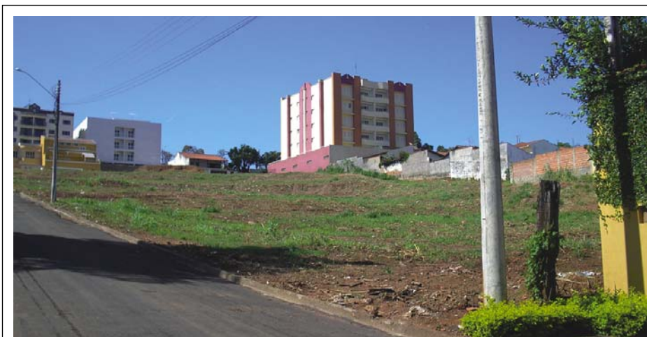
Figura 96. Vista atual da voçoroca Adalgisio Leite, que foi aterrada, embora ainda não urbanizada, pertencente à Prefeitura.
