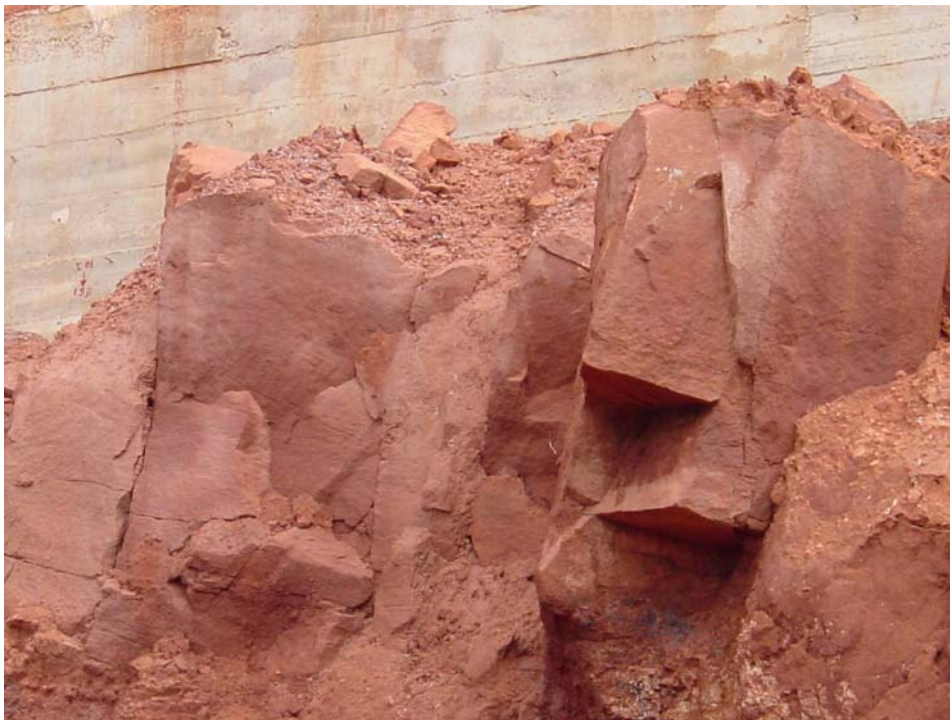
Figura 11- Arenito apresentando descontinuidades sub-horizontais e sub-verticais.
