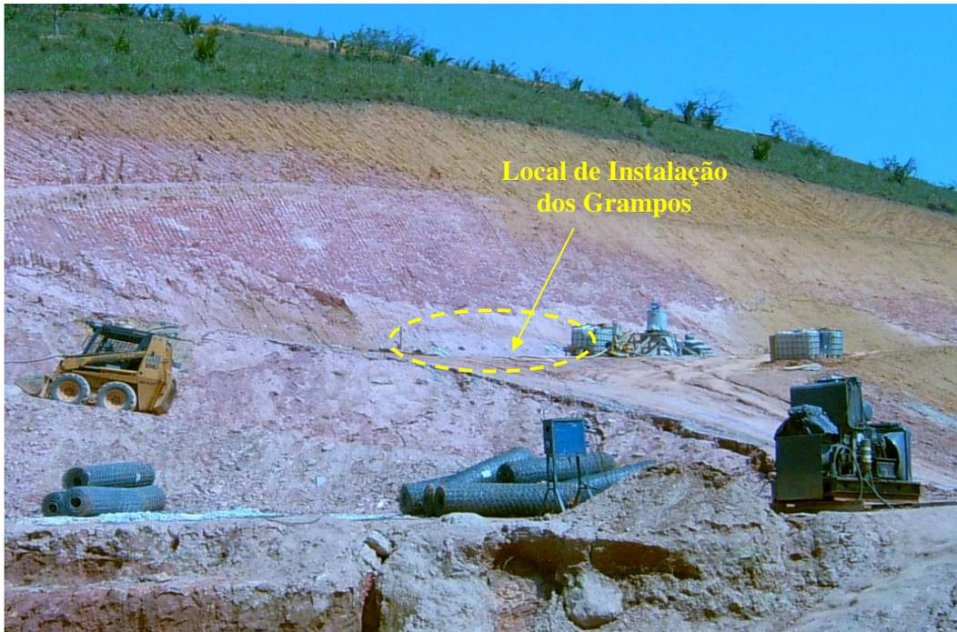
Figura 3.4 – Vista da área do talude adotada para instalação dos grampos.
