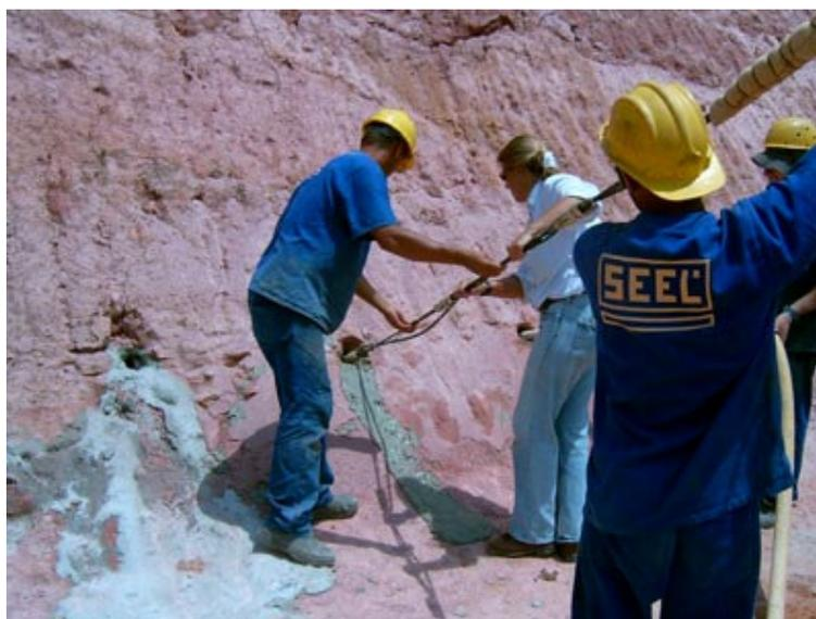
Figura 3.26 – Inserção da barra instrumentada no furo.
