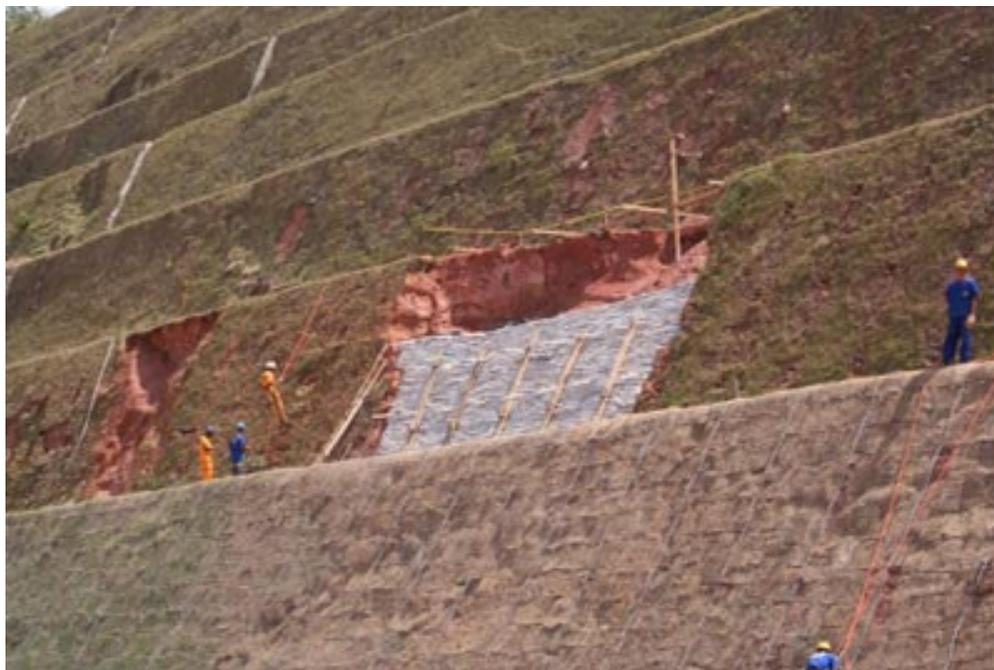
Figura 3.1 – Vista do talude em solo grampeado.
