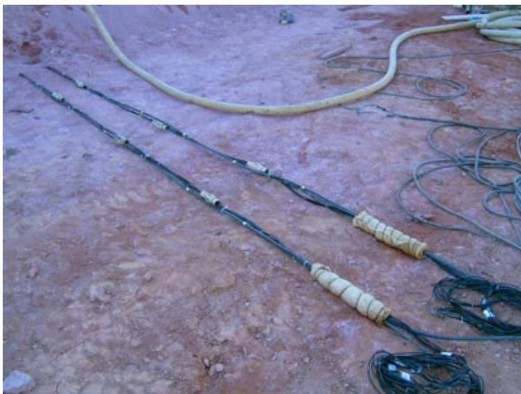
Figura 3.20 – Barras de aço prontas para serem inseridas.
