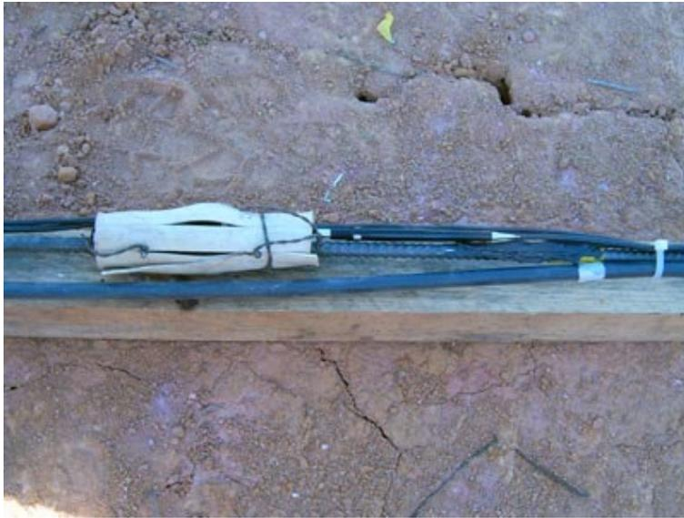
Figura 3.19 – Detalhe da barra de aço, com mangueira de reinjeção e centralizador acoplados.
