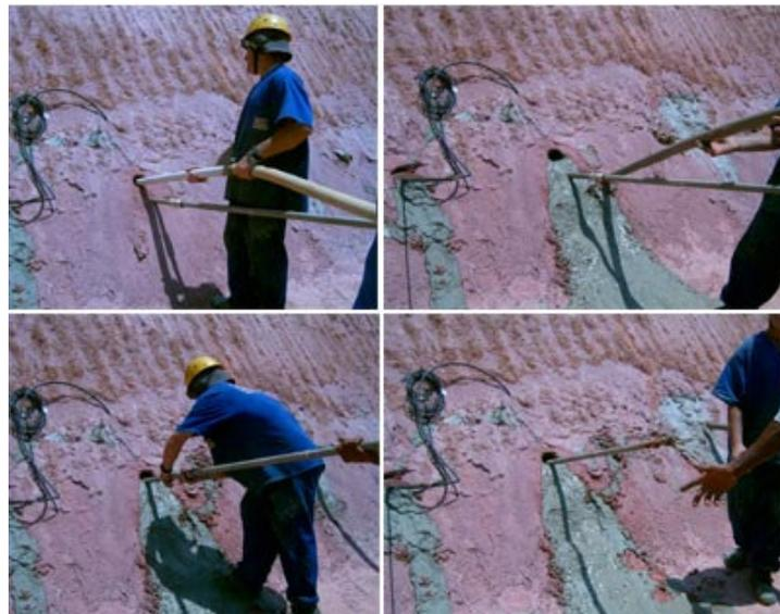
Figura 3.29 – Sequência do processo construtivo dos grampos convencionais.
