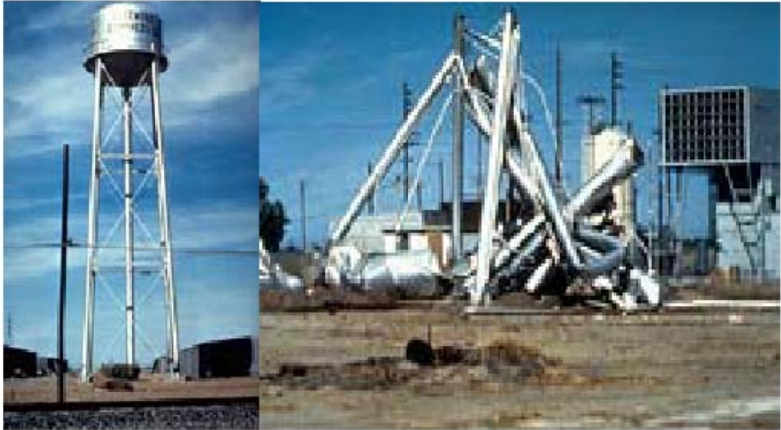
Figura I.1 Reservatório elevado típico apoiado sobre uma estrutura tubular esbelta (antes e depois do terremoto Imperial Valley, Califórnia, 1979 [5])
