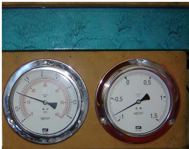
Figura 3.6 – Instalação do manômetro e manovacuômetro na mesma linha de centro.
