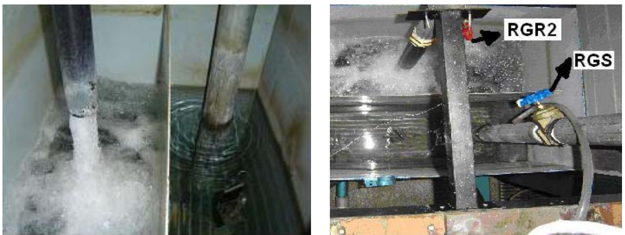
Figura 3.2 – Instalação da placa metálica de separação dos reservatórios de sucção e recalque.
