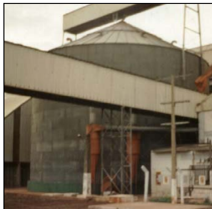
Figura 14. Silo II (idêntico ao Silo I)
