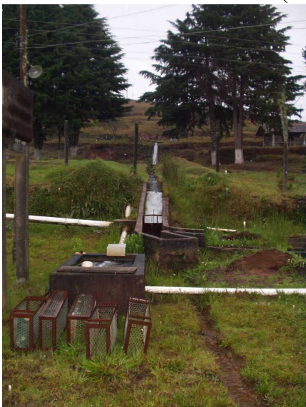
Canaletas para captação
