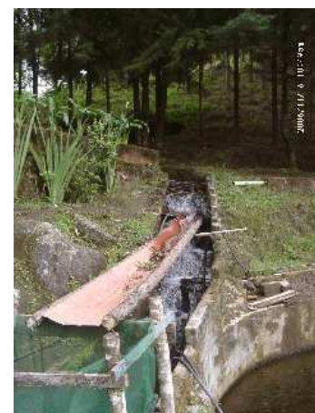
Canaletas para captação
