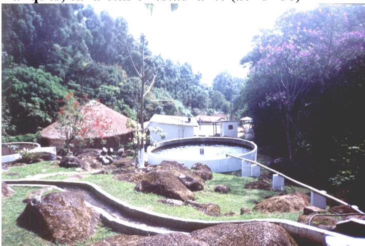
Tanques, canaletas e salas para beneficiamento
