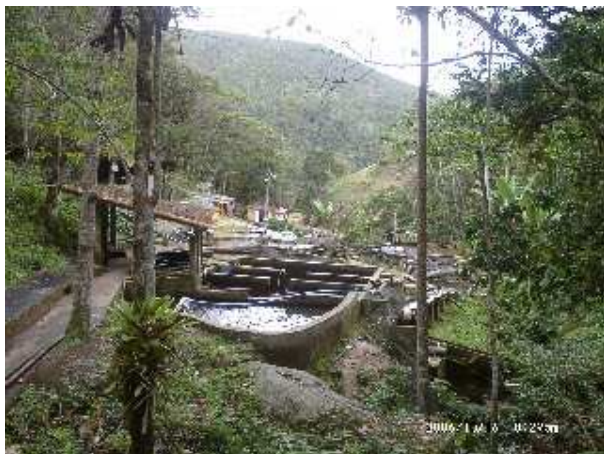
Tanques e canaletas
