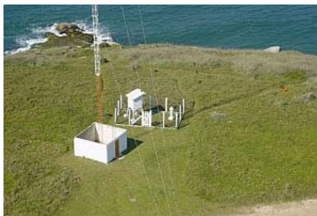
Figura 3-2 RF Sta. Marta – SC.
