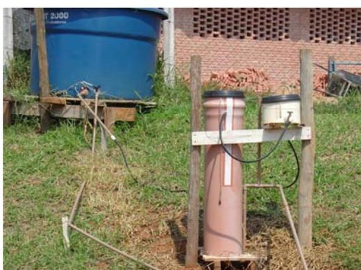
Figura 5A – Vista frontal do da caixa de alimentação e do filtro lento
