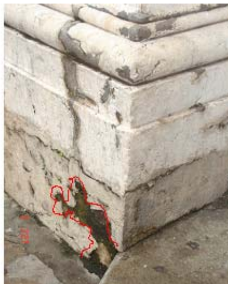
Figuras 78 e 79 – Intervenção feita na portada em cantaria e a presença das alterações no seu aspecto físico na Fachada Principal do Antigo Palácio
