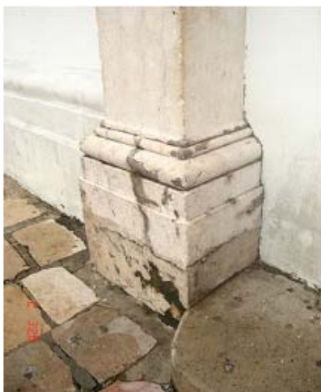
Figuras 78 e 79 – Intervenção feita na portada em cantaria e a presença das alterações no seu aspecto físico na Fachada Principal do Antigo Palácio
