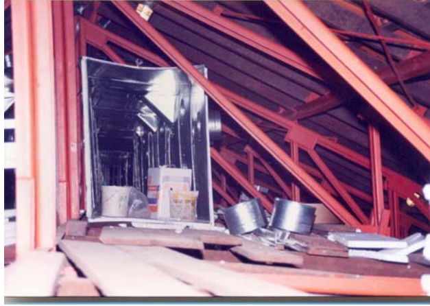
Figura 35: Estrutura metálica do telhado da Igreja de Santo Alexandre.
