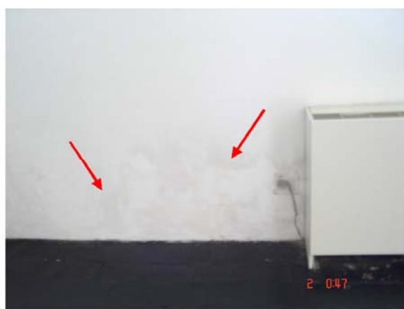
Figuras 63 e 64 – Manchas de umidade nas paredes
