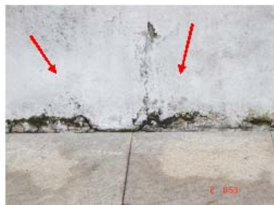
Figuras 70 e 71 – Detalhe da mancha de umidade na base do paramento.
