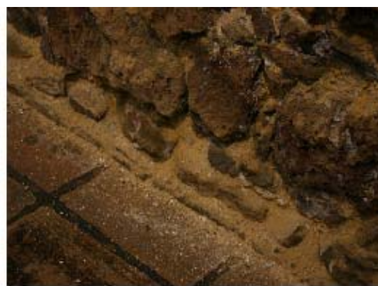
Figuras 98 e 99 – Parede descarnada do transepto
