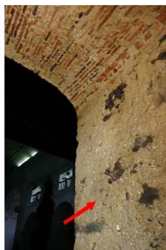
Figuras 94 e 95 – Parede descarnada sob o coro.
