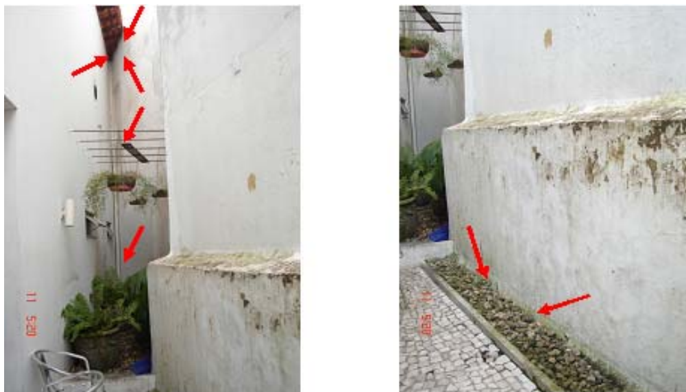
Figuras 100 e 101 - Telhado do prédio da sorveteria
