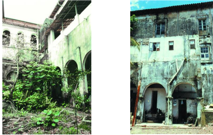
Figuras 40 e 41: Fachada Posterior.
