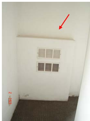
Figura 67 – Instalações de Ar condicionado
