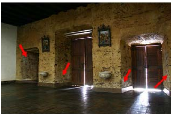
Figuras 94 e 95 – Parede descarnada sob o coro.
