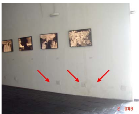
Figuras 63 e 64 – Manchas de umidade nas paredes
