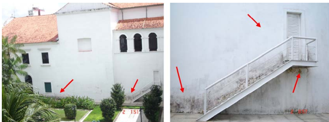
Figuras 68 e 69 - Fachada lateral esquerda do Pátio interno I
