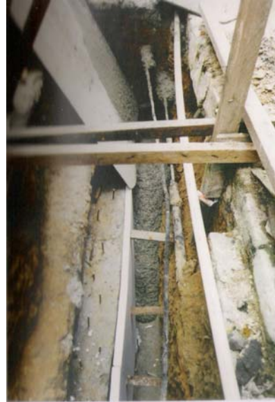
Figuras 54 e 55: Fosso de concreto.
