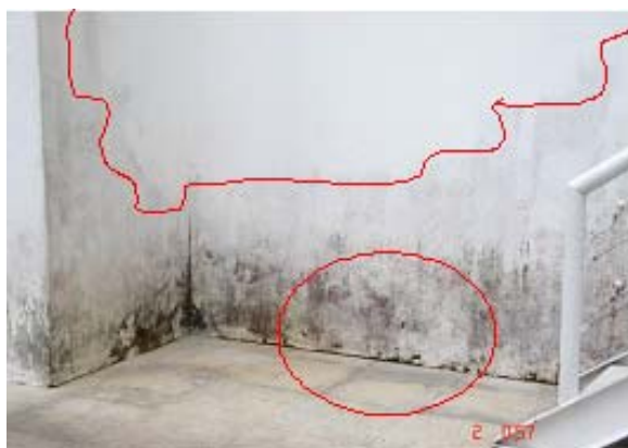
Figuras 70 e 71 – Detalhe da mancha de umidade na base do paramento.
