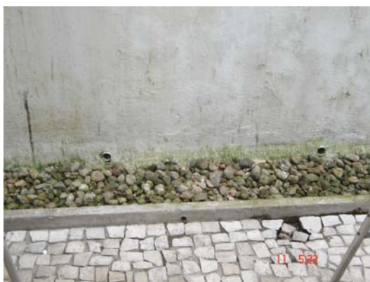
Figura 136 - Canaleta de Seixo e Pavimentação
