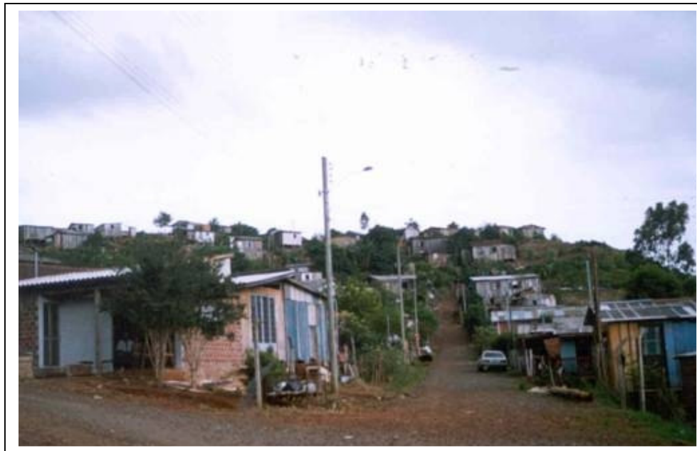
FIGURA 22 – LOTEAMENTO POLETTTO: ÁREA OCUPADA IRREGULARMENTE NO BAIRO PROGRESSO: Área constituída por morros, bastante acidentada e insegura, com pouca vegetação, e casas pequenas com mínima infra-estrutura. Fonte: SCOLARI, Rosana. 2005.
