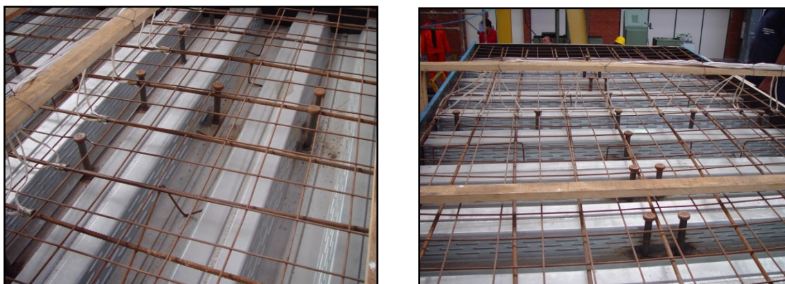
Fig. III-8 Extensômetros nas barras de aço principais da laje de concreto.
