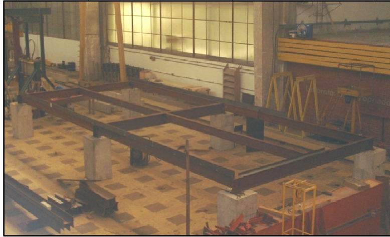
Fig. V-11 Montagem da grelha metálica.
