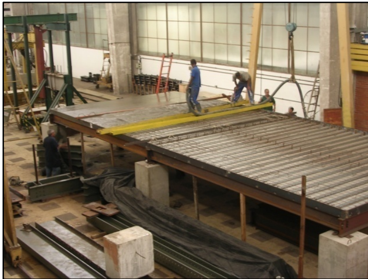
Fig. V-14 Concretagem da laje.
