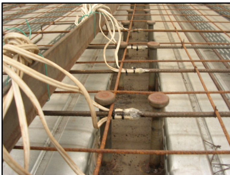
Fig. V-52 Vista dos extensômetros colados nas armaduras das ligações mistas.
