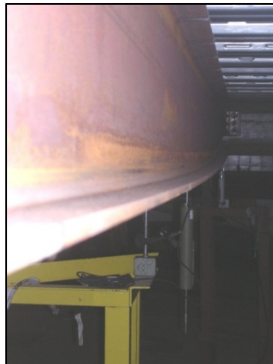
Fig. V-54 Medição da flecha no vão viga secundária interna (FL_VSN).
