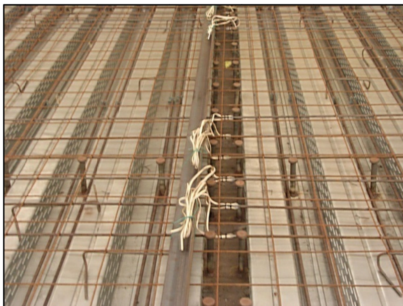
Fig. V-13 Detalhe das armaduras na região do encontro entre a VP e a VS.
