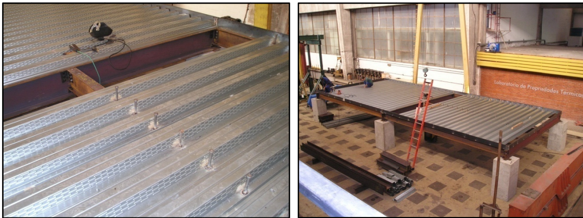
Fig. V-12 Montagem da forma metálica e soldagem dos conectores.
