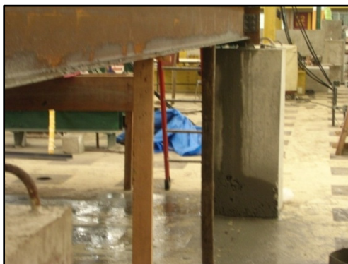
Fig. V-42 Escoramento das vigas do protótipo da laje.
