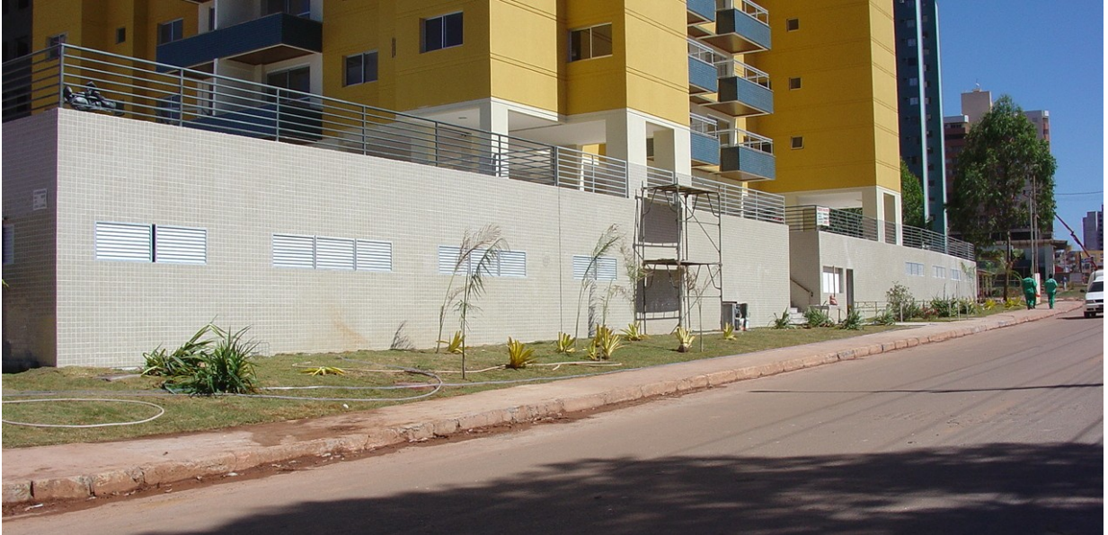
FIGURA 12 – Esquina Av. Castanheiras com Rua 05 Norte
