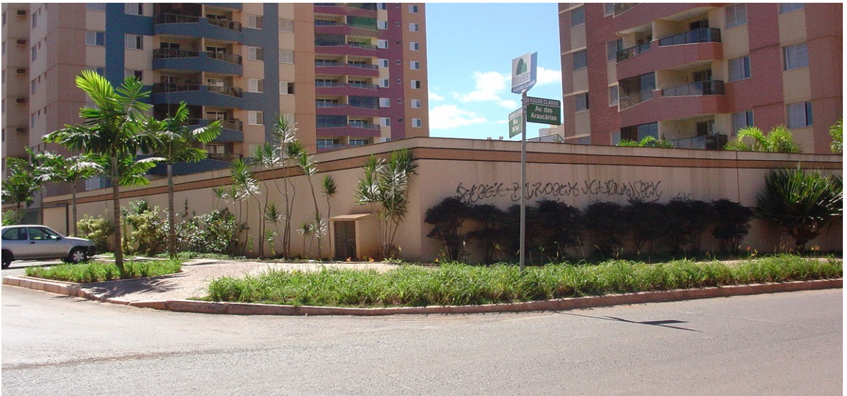
FIGURA 13 – Esquina Av. Araucárias com Rua 09 Sul (arquivo da autora)
