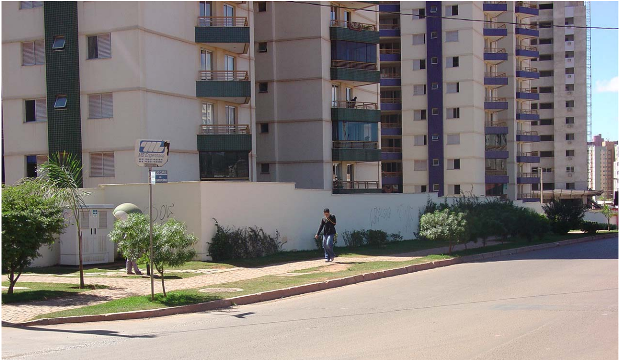
FIGURA 14 – Esquina Av. Araucárias com Rua 21 Sul (arquivo da autora)
